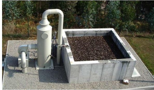
Figura 27. Biofiltro para el tratamiento biológico de gases (ECOTEC, 2020).
