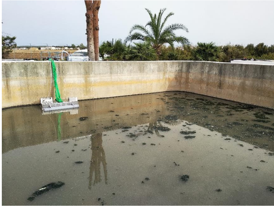
Figura 43. Laguna anaerobia I.
