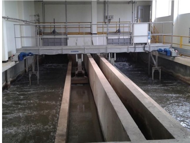
Figura 7. Puente desengrasador longitudinal (ESTRUAGUA, 2023).
