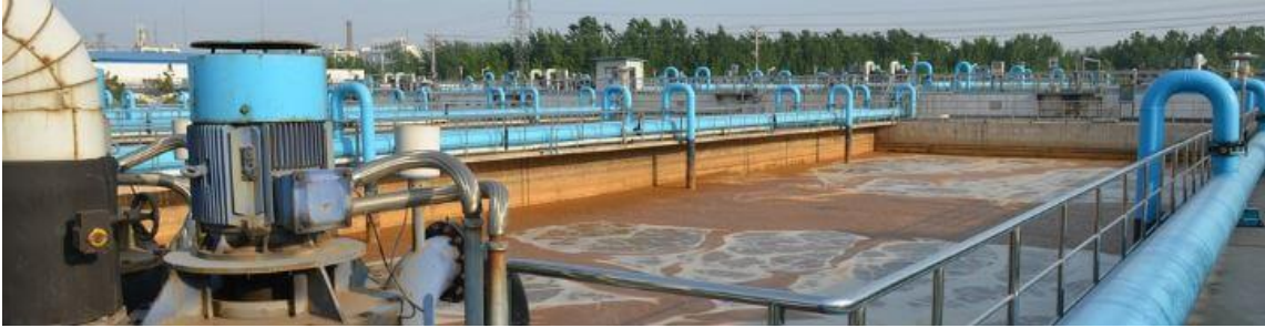
Figura 30. Fangos activos como eliminación de malos olores (Aguas Industriales, 2014).
