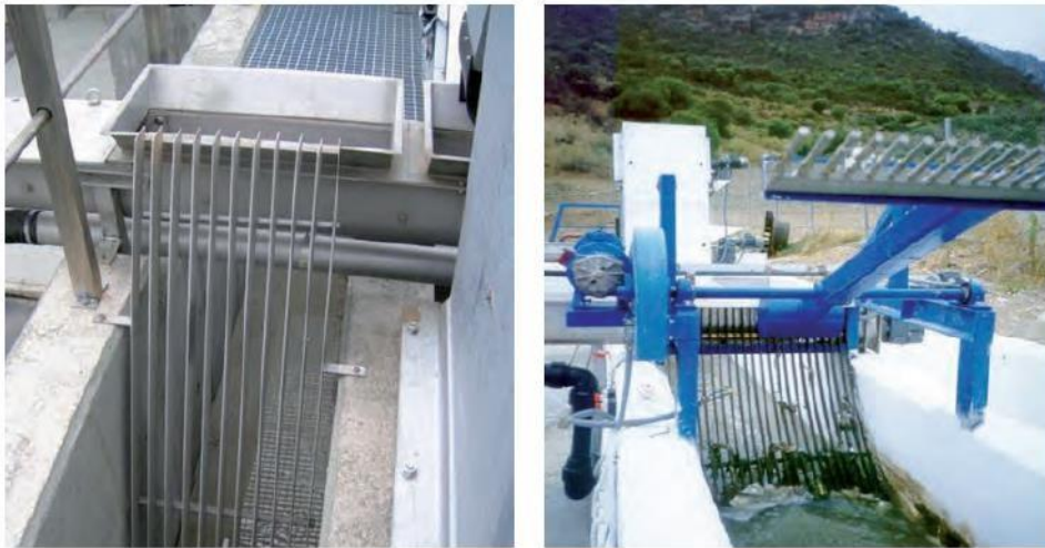
Figura 5. A) Reja de gruesos manual (izquierda). B) Reja de finos automática (derecha) (de Miguel, 2010).
