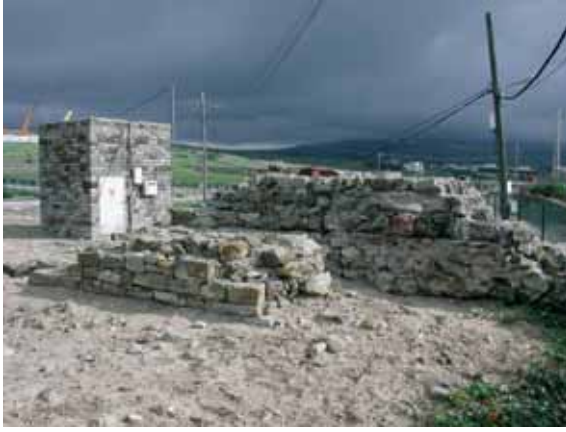
Figura 43. Detalle de las estructuras emergentes de una de las torres y del transformador eléctrico de nueva construcción, utilizando técnicas similares a las de la edificación del yacimiento arqueológico.
