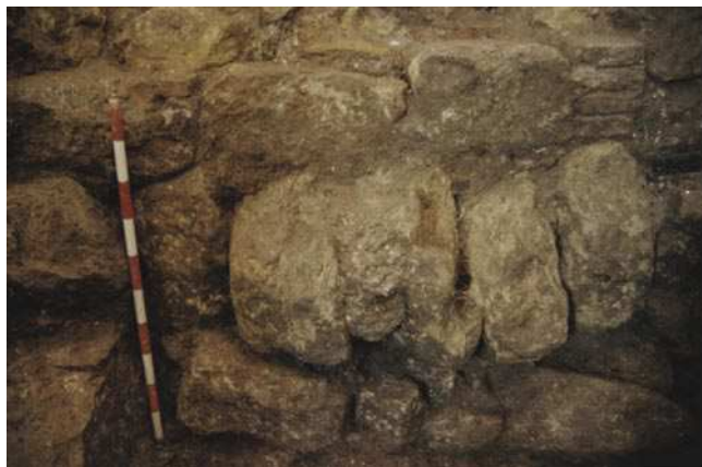
LÁM. II. Muro de cierre sur de la Mid'a .
