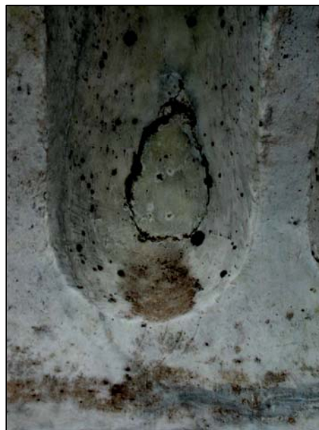
Lám. 11.- Detalle del fuste de columna TR052.
