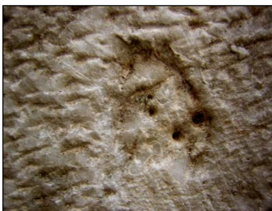
Lám. 12.- Detalle de los centros realizados en la cara inferior del fuste de columna TR068.
