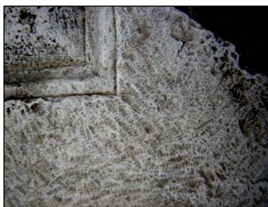
Lám. 8.- Detalle de las líneas que sirvieron de guía para realizar el sofito de la pieza TR023.
