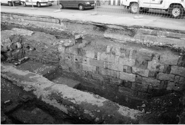
LÁM. IV. Vista general de la muralla donde se aprecia su técnica constructiva.
