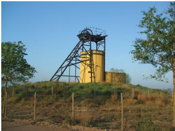
Estado actual Mina Sta. Elisa
