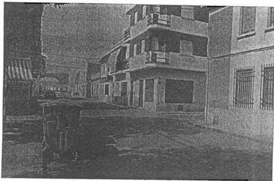
FOTO 4. Visita parcial de la calle de la Concordia, antigua C. José A. Primo de Rivera. (Vect. fotográfico S-N). Sin duda el sector que se ubica y desarrolla al margen septentrional del trazado ferroviario Córdoba-Sevilla, se ha transformado en el más activo en todos los aspectos. En dicho espacio se agrupan los locales comerciales, lúdicos, financieros y de ocio, así como el mayor número de viviendas y habitantes.
