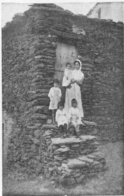
Fig. 19. — Detalle de construcción en Capleira. — La pendiente de las calles impone la construcción de escaleras de acceso a la vivienda superior. Las puertas están divididas en dos partes: una superior y otra inferior, como en los pueblos extremeños, gallegos, etc.
