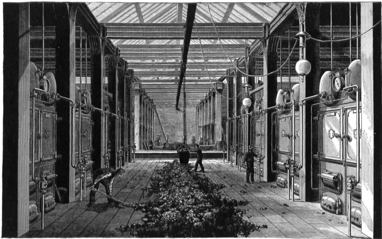
Calderas Babcock & Wilcox en la Estación, Deptford, de la London Electric Supply Corporation, Limited ; 25 calderas instaladas en 1888-89, para suministrar vapor á las Máquinas Compound, formando un conjunto de 12,000 caballos indicados. La Estación cuando esté completada tendrá 120,000 caballos.
