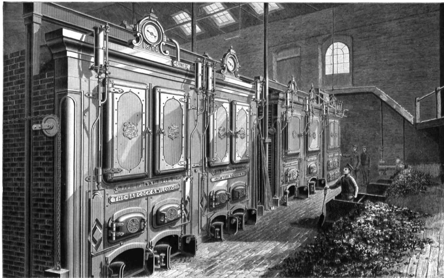
Calderas Babcock y Wilcox, instaladas en la fábrica de hilados "La Foudre" de la Sociedad Anónima de Hilados y Tejidos Pouyer-Quertier, Petit-Quevilly cerca de Rouen. 2 Calderas montadas en Diciembre, 1885, 2 en Setiembre, 1886, 1 en Junio, 1890, en total: 708 m. c. de superficie de calefacción.
