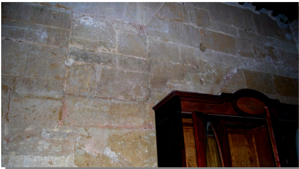
Figura 4.1-Restos de un vano cegado y huella de escalera. (Fotografía: Rocío Velasco García).
