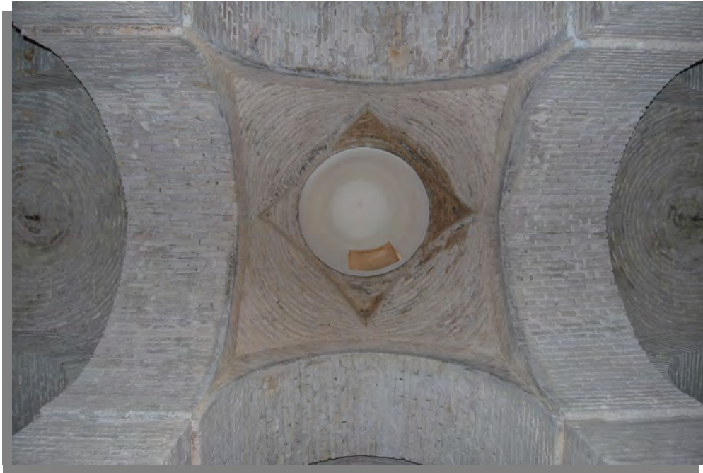
Figura 12.41-Cúpula central con cupulín abierto en un solo vano, para la salida de humos de la cocina. (Fotografía: Rocío Velasco García).
