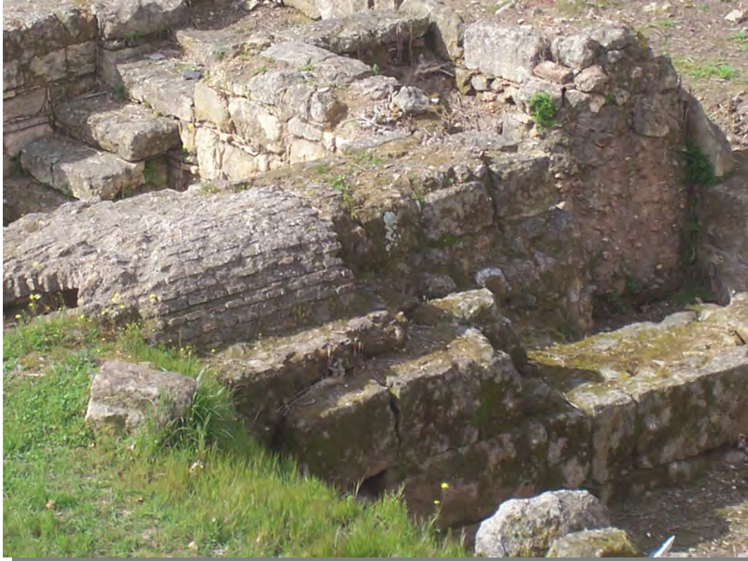
Figura 3.3- Superficie de la bóveda de cañón de una estancia. (Fotografía: Rocío Velasco García).
