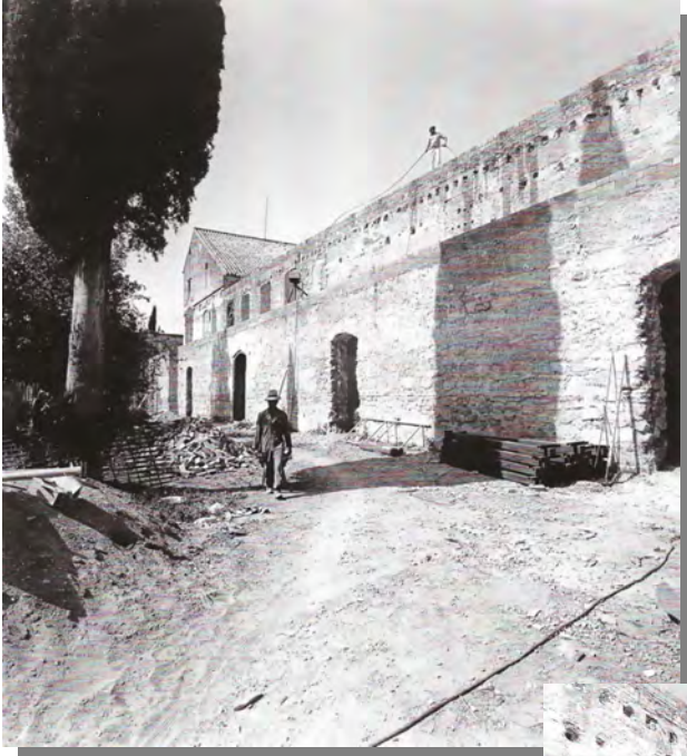
Figura 11.2-Aspecto que presentaba el edificio durante las obras. (APEALT).
