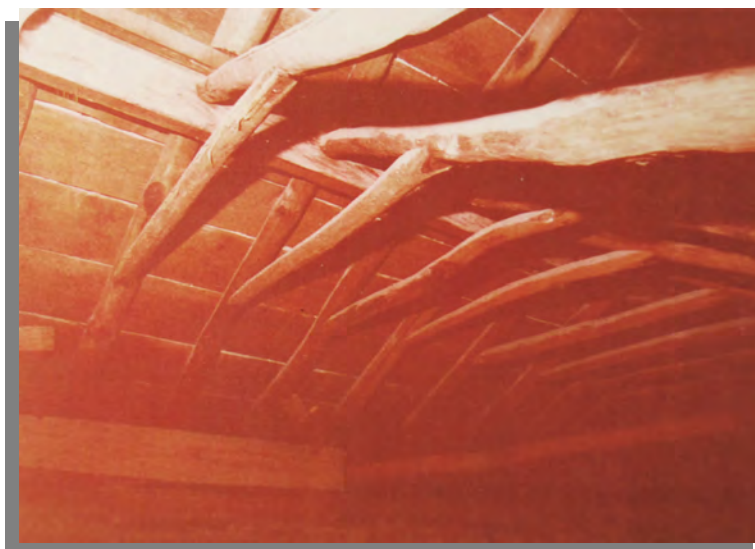
Figura 11.47-Interior de una de las cubiertas del Palacio. (Fotografía: Carlos Luca de Tena, APEALT).
