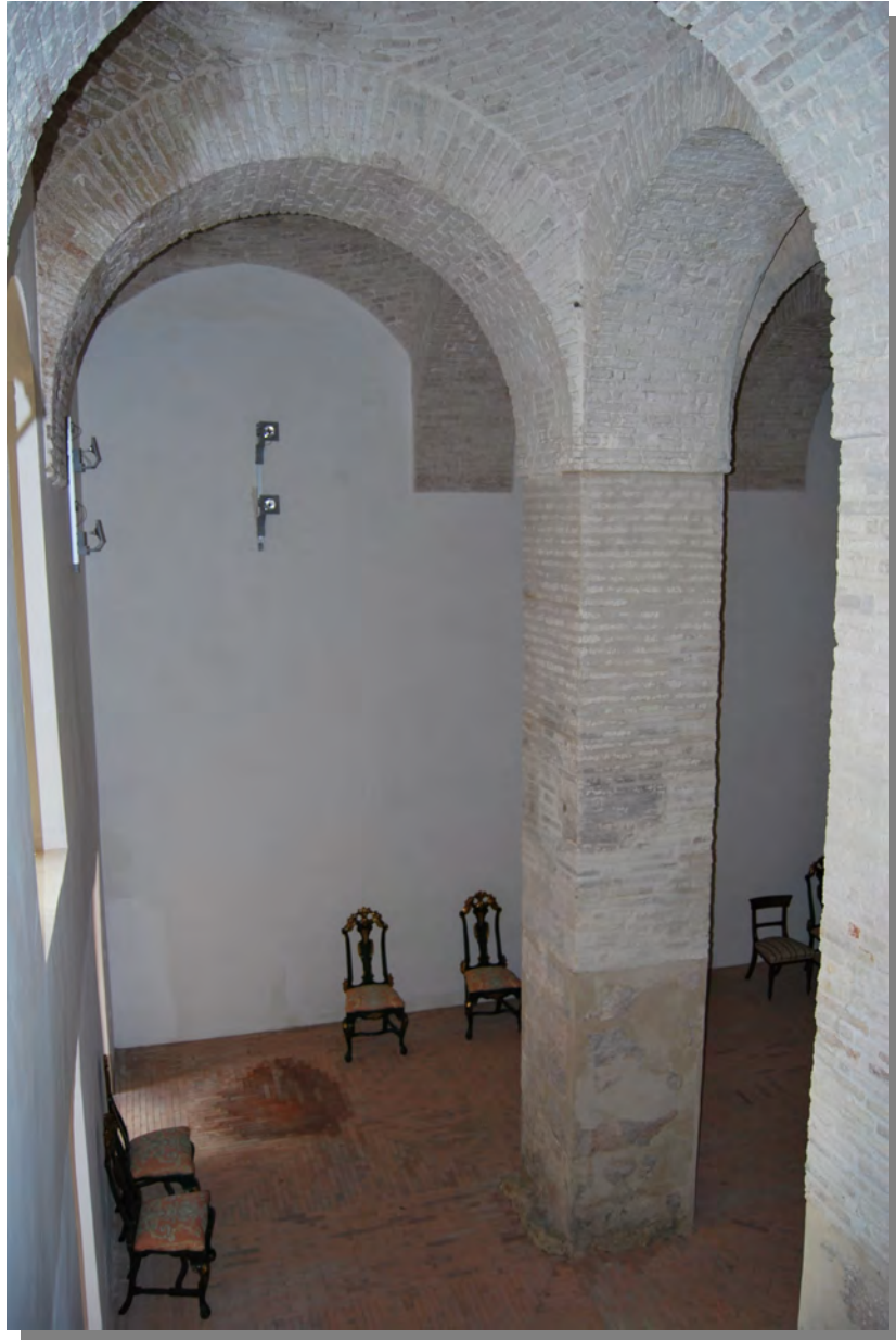
Figura 12.35-Vista lateral de la antigua cocina. (Fotografía: Rocío Velasco García).
