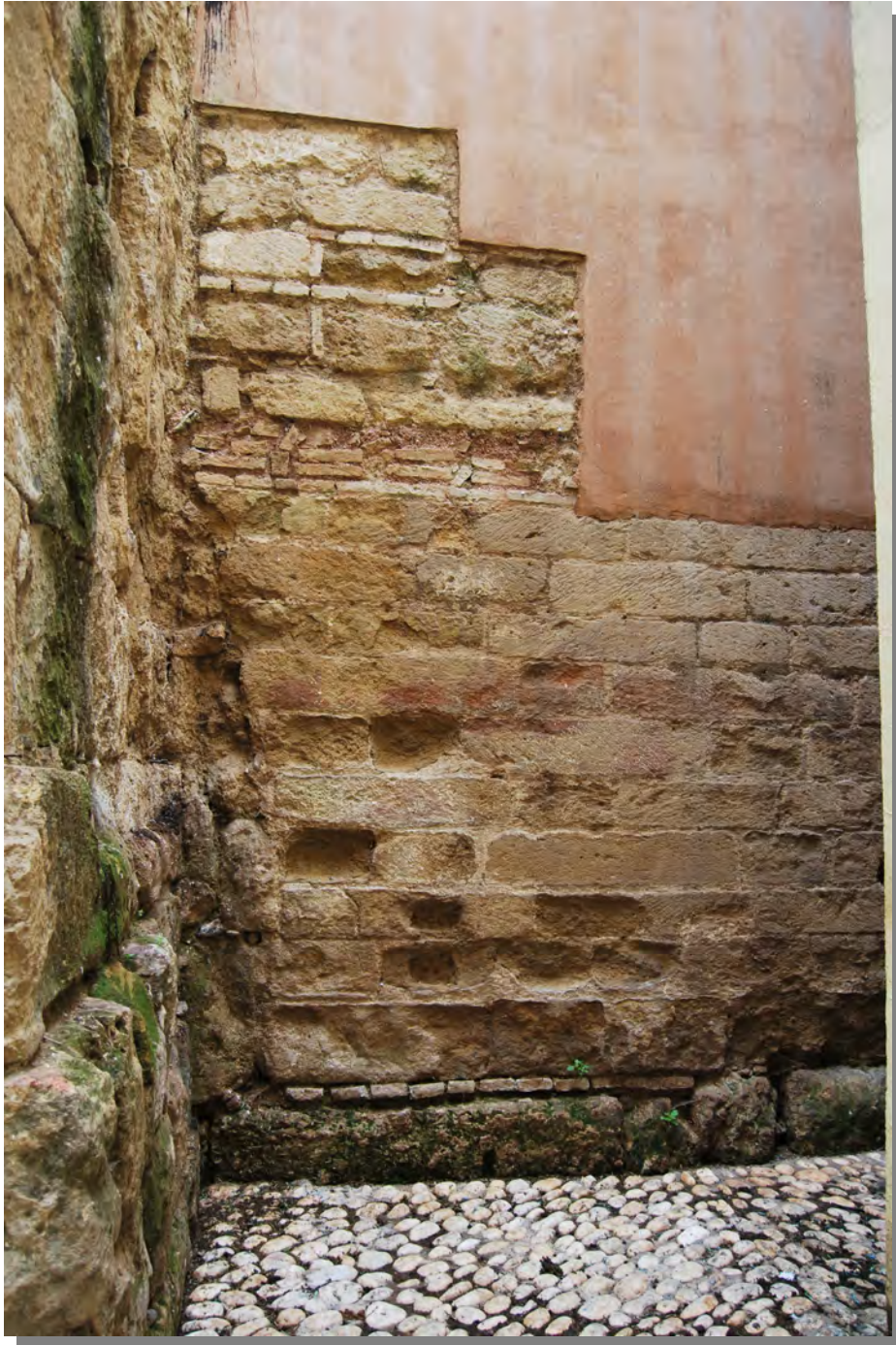
Figura 3.11- Aparejo del muro occidental de la torre norte del Alcázar. (Fotografía: Rocío Velasco García).
