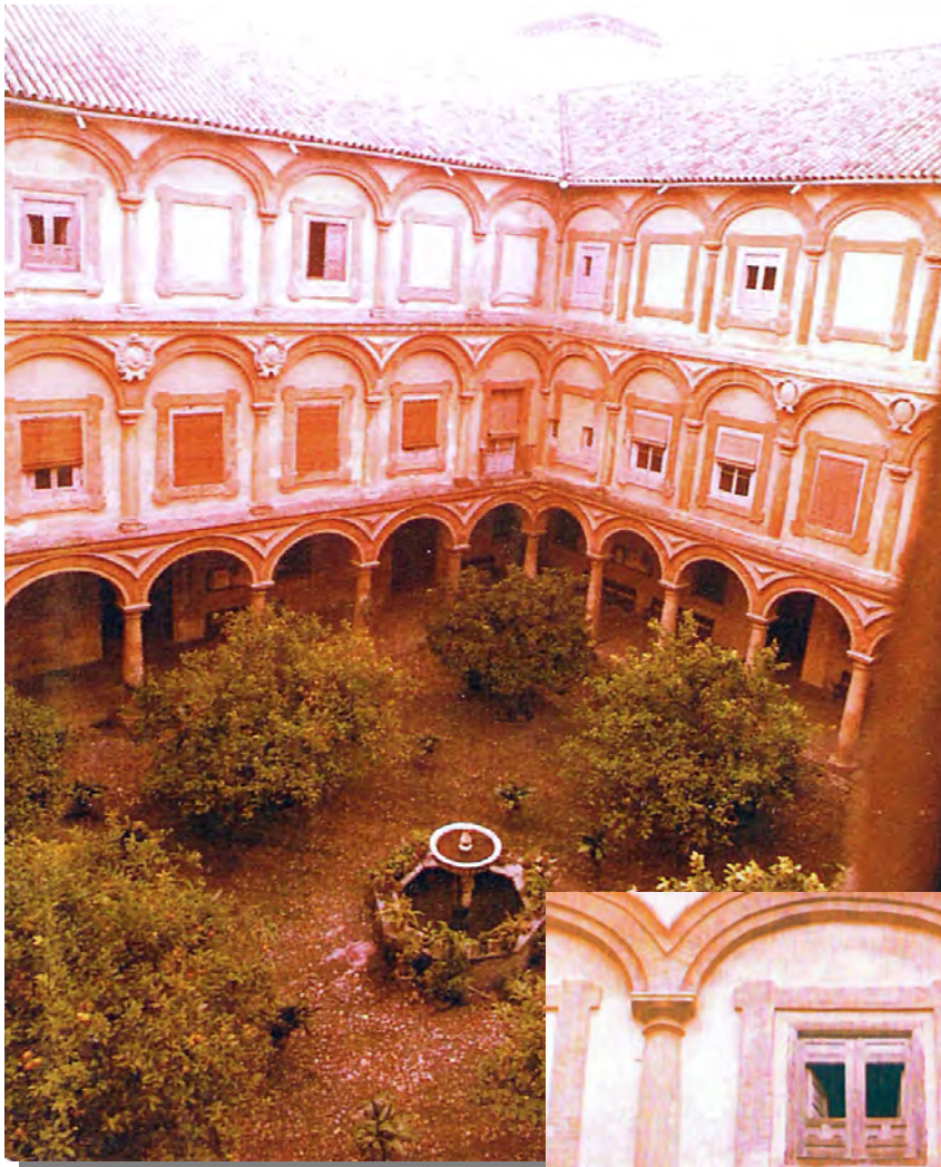
Figura 11.38-Estado del patio principal en 1980. (Fotografía: Carlos Luca de Tena, APEALT).
