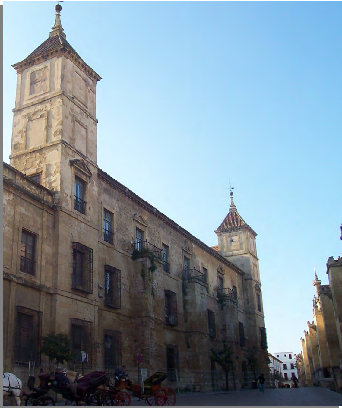
Figura 5.1-Vista parcial de la fachada oriental. (Fotografía: Rocío Velasco García).
