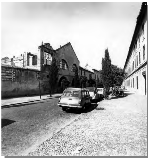
Figura 11.1-Aspecto que presentaba la fachada del edificio durante las obras. (APEALT).
