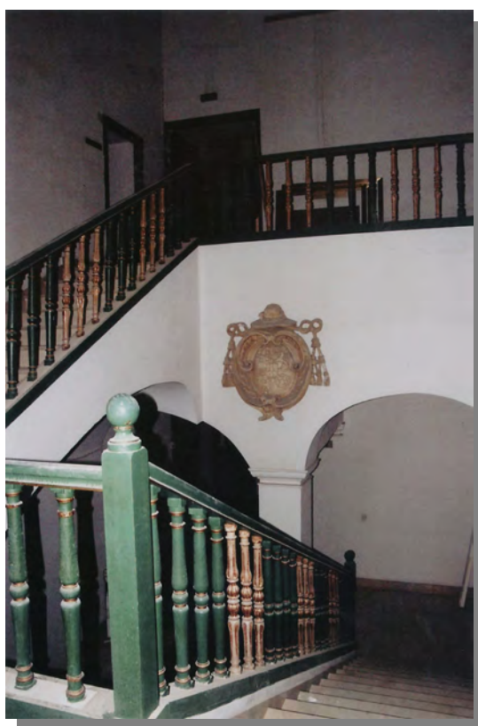
Figura 12.21-Tramo superior de la escalera de Mardones, antes de la intervención. (Fotografía: Rocío Velasco García).
