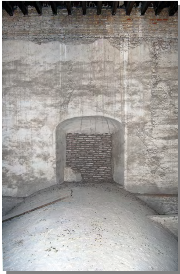
Figura 7.6-Exterior de la bóveda de la Capilla de Nuestra Señora del Pilar en primer plano. Al fondo, una puerta de la segunda planta cegada con ladrillo. (Fotografía: Rocío Velasco García).
