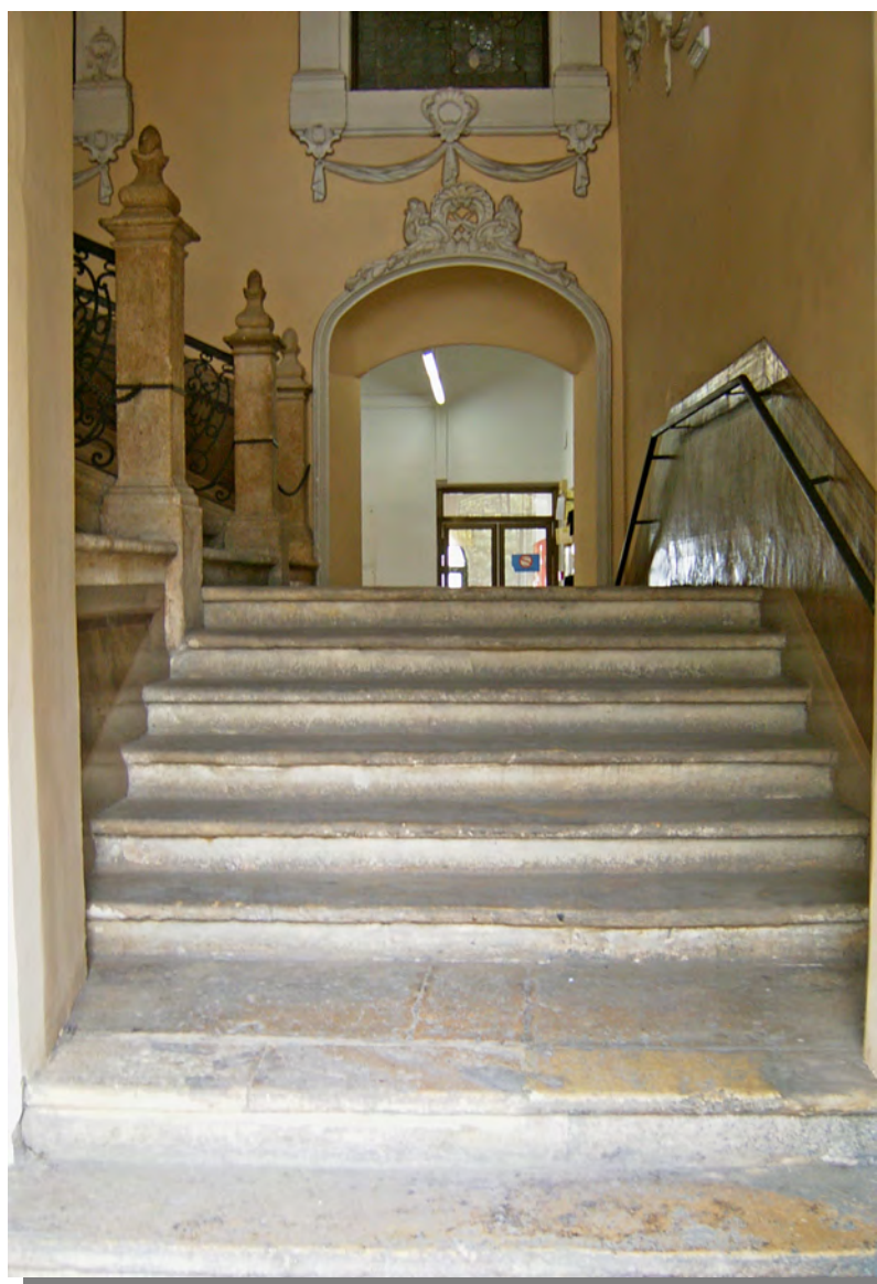
Figura 8.2-Primer tramo de subida de la escalera. (Fotografía: Rocío Velasco García).
