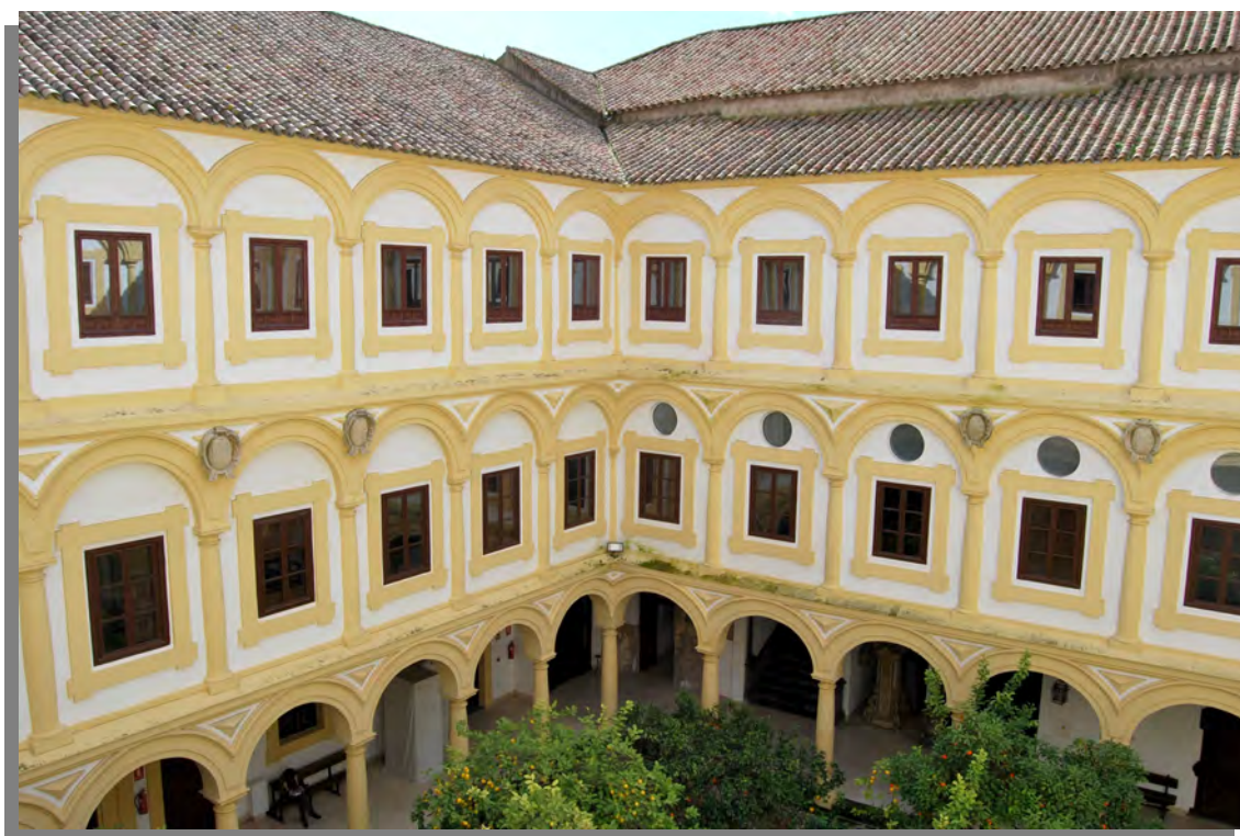
Figura 5.31-Fachadas de las galerías altas que abren al patio. (Fotografía: Rocío Velasco García, 2010).
