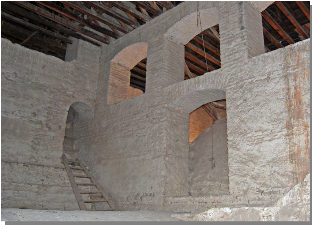
Figura 7.7- Estructura en ladrillo sobre la bóveda de la Capilla. Al fondo a la izquierda, se dispone una escalera de madera por la que se accede a la cúpula de la escalera principal del Palacio. (Fotografía: Rocío Velasco García).
