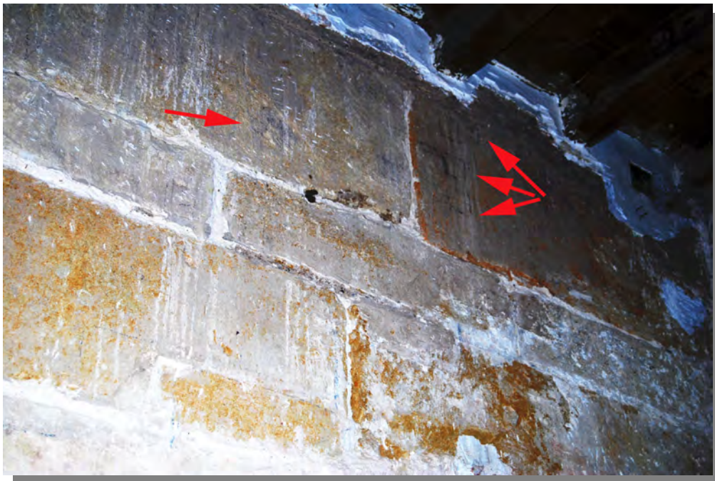
Figura 5.34-Grafitos de lo que parece ser la disposición de vigas. (Fotografía: Rocío Velasco García).
