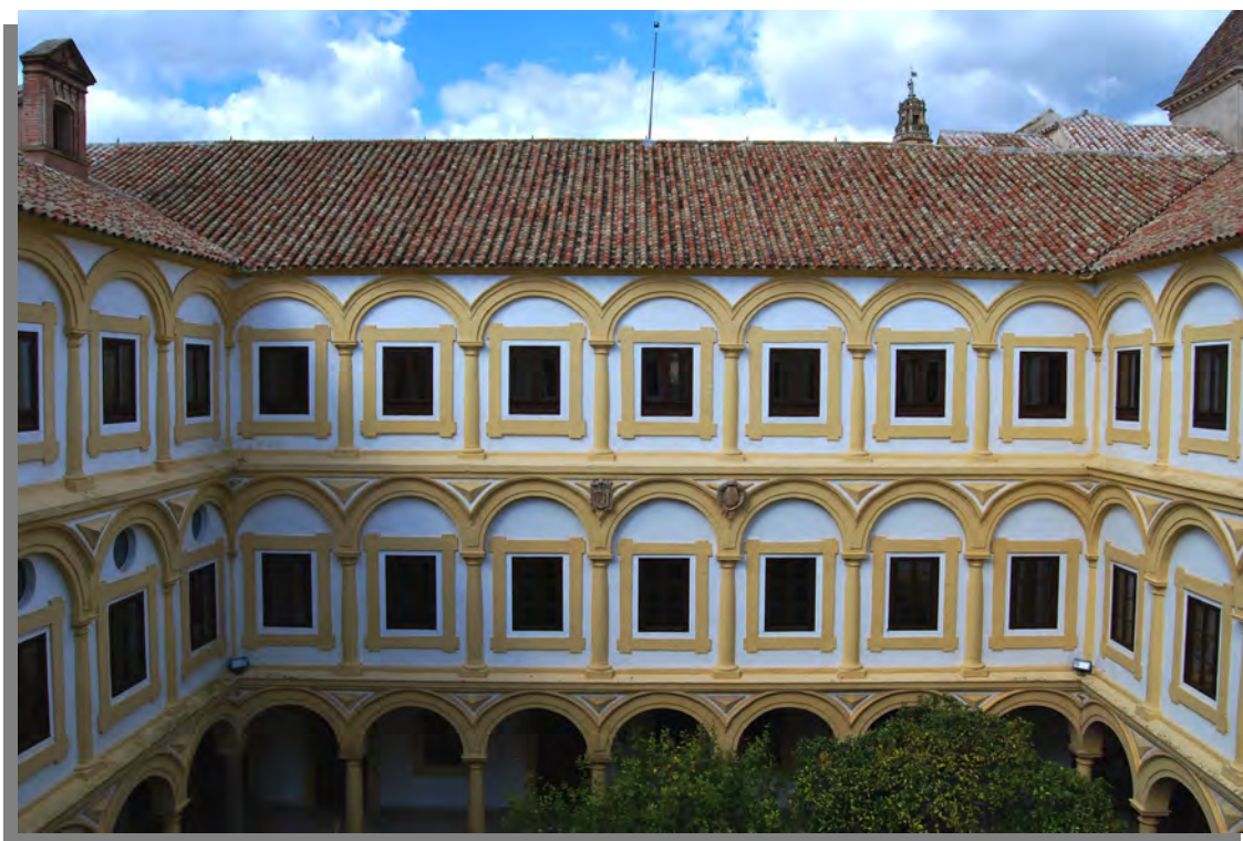
Figura 4.5- Fachada de la galería norte del Patio Principal. (Fotografía: Rocío Velasco García).
