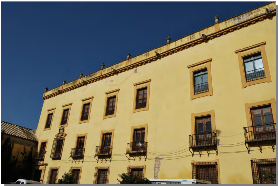
Figura 5.26-Crujía hacia poniente. Fachada norte del patio de recibo. Estado actual. (Fotografía: Rocío Velasco García).
