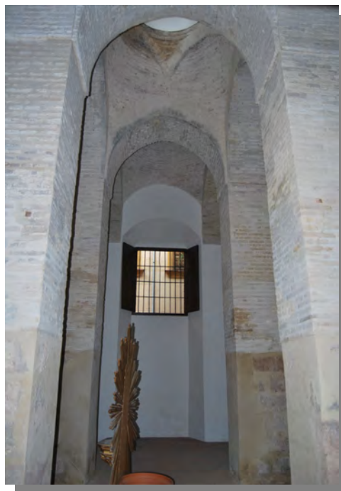
Figura 12.29-Estado actual de la antigua cocina. (Fotografía: Rocío Velasco García).
