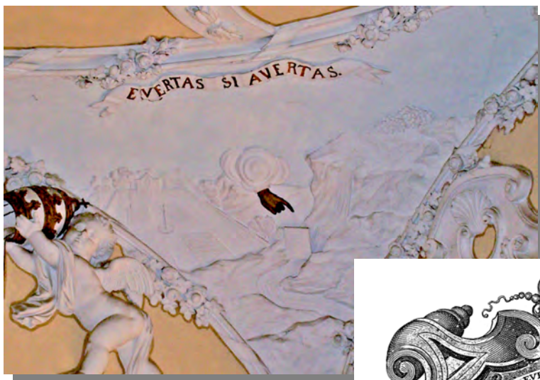
Figura 8.27-Detalles de la decoración de la pechina del ángulo sureste de la escalera, con el mote “EVERTAS SI AVERTAS”. (Fotografía: Rocío Velasco García).
