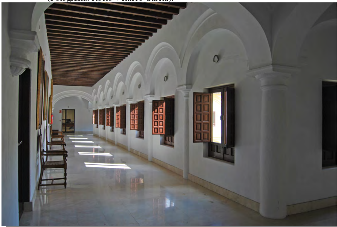
Figura 12.16-Galería norte de la segunda planta antes de la intervención. (Fotografía: Rocío Velasco García).
