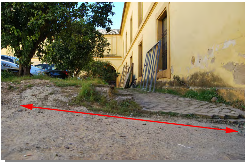
Figura 5.24-Detalle del desnivel entre el patio de recibo y la crujía sur del Palacio que abre a la calle Amador de los Ríos. (Fotografía: Rocío Velasco García).
