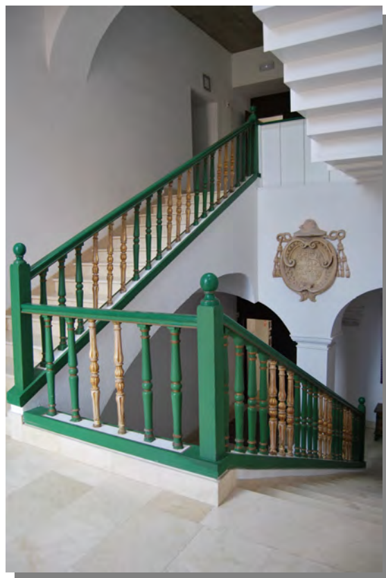
Figura 12.22-Arranque de la nueva escalera proyectada por Jurado, en la escalera de Mardones. (Fotografía: Rocío Velasco García)
