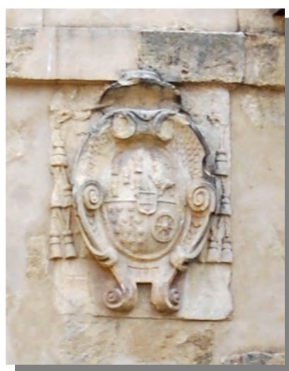
Figura 5.5- Escudo del obispo D. Diego de Mardones en la cornisa de la primera planta de la fachada septentrional de la torre norte. (Fotografía: Rocío Velasco García).
