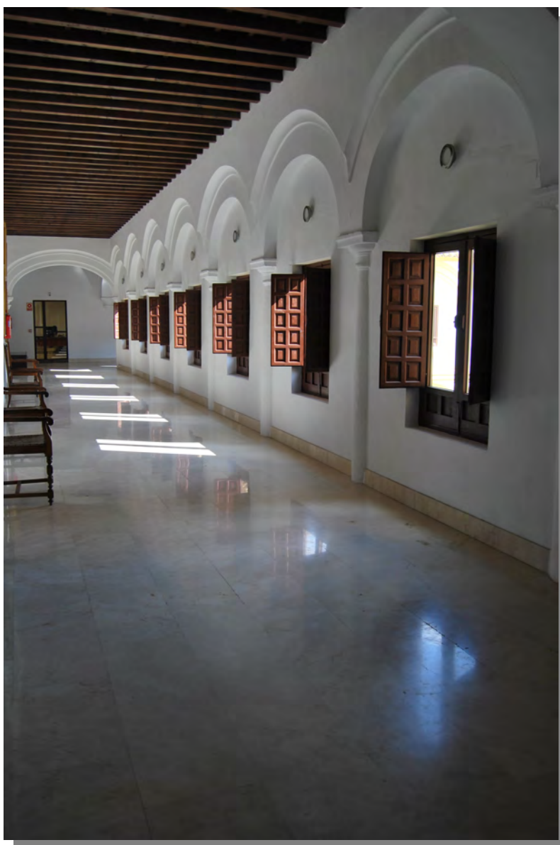
Figura 7.23-Cerramiento interior de la galería de la segunda planta; estado actual. (Fotografía: Rocío Velasco García).
