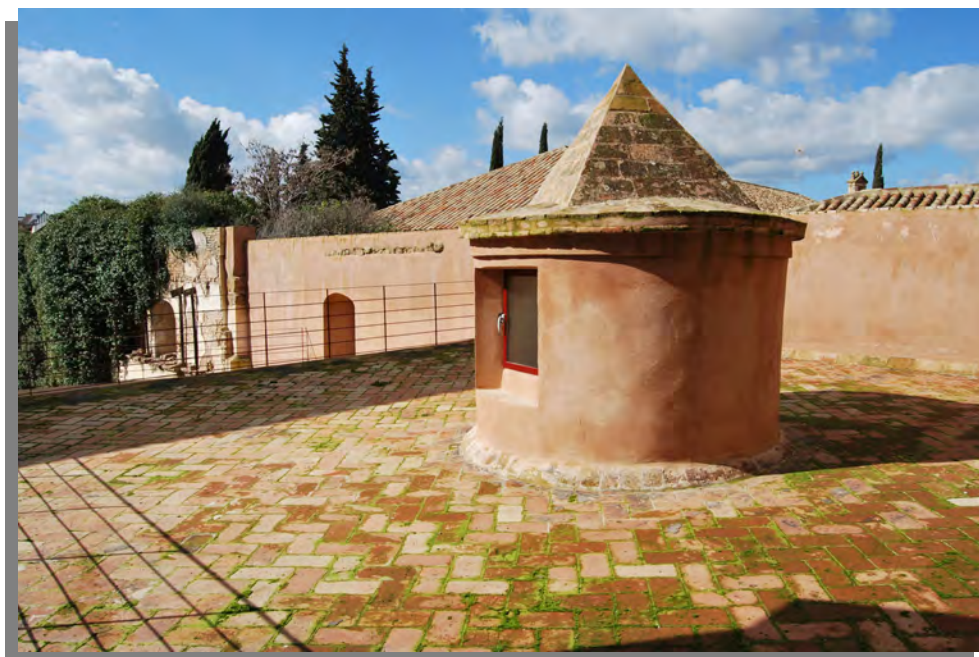
Figura 12.42-Cubierta exterior de la cocina. (Fotografía: Rocío Velasco García).
