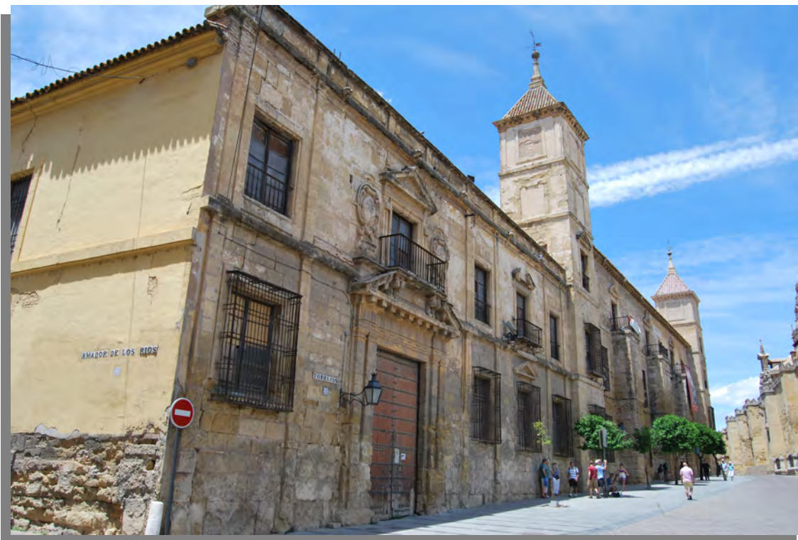
Figura 5.10-Crujía oriental de dos alturas a calle Torrijos.(Fotografía: Rocío Velasco García).
