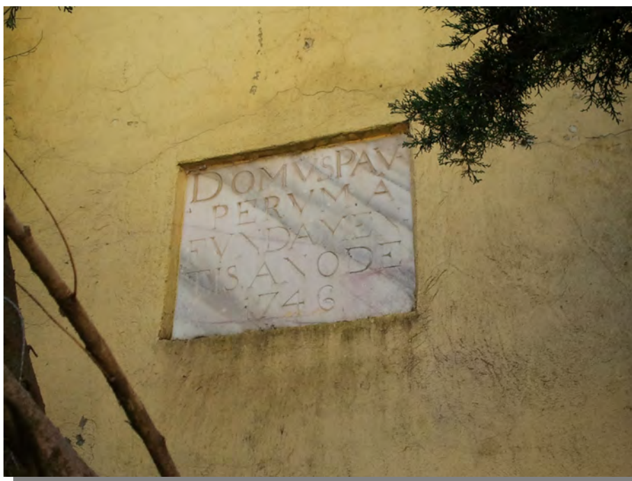
Figura 7.28-Placa de mármol con inscripción, en la fachada de poniente del patio de recibo. (Fotografía: Rocío Velasco García).
