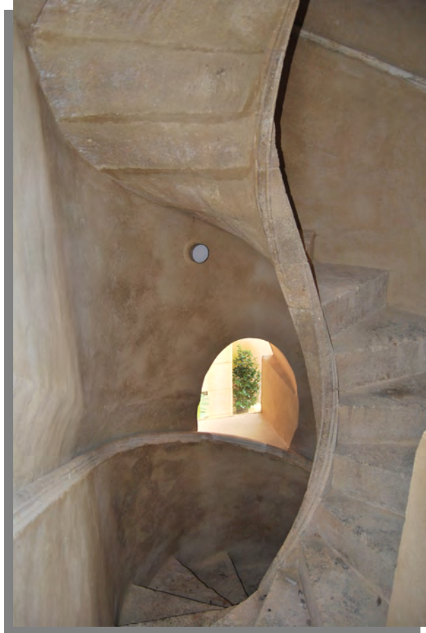
Figura 4.26-Escalera de caracol cerca de la Capilla del Palacio. (Fotografía: Rocío Velasco García).
