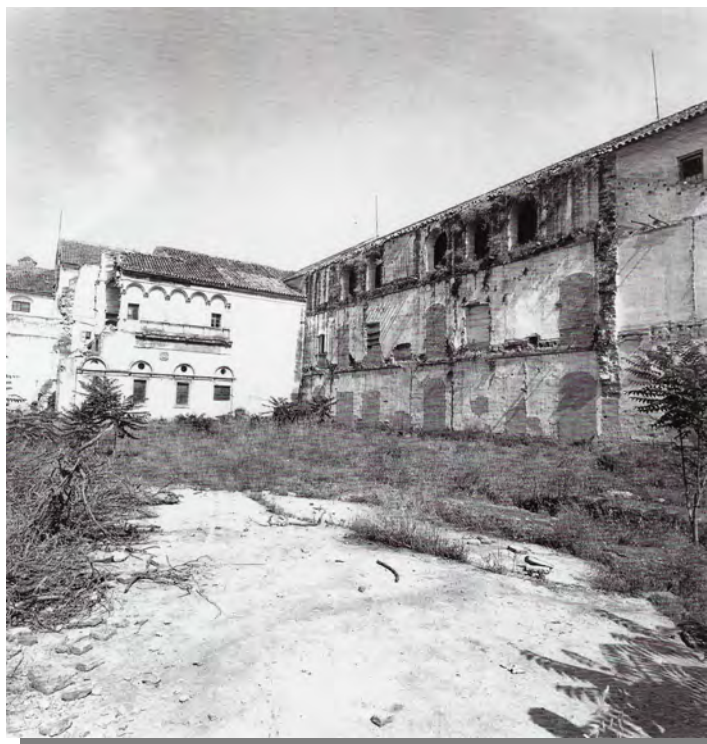
Figura 4.17-A la derecha de la imagen se encuentra la crujía del siglo XVII-XVIII, que fue demolida en el siglo XX. (APEALT).
