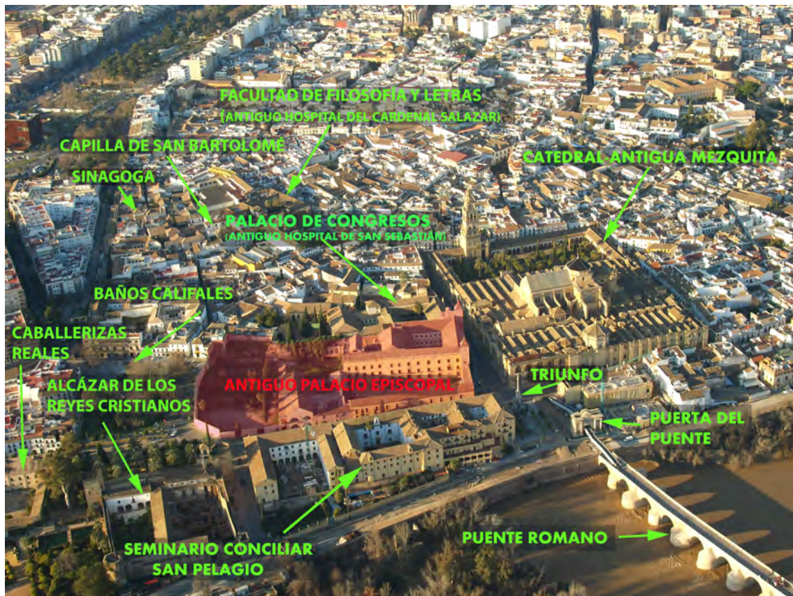
Figura 2. Vista aérea del entorno del antiguo Palacio Episcopal de Córdoba.
