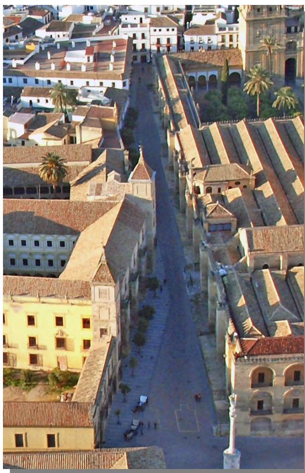
Figura 6.8-Vista aérea de la fachada oriental del Palacio y la fachada occidental de la Mezquita-Catedral.
