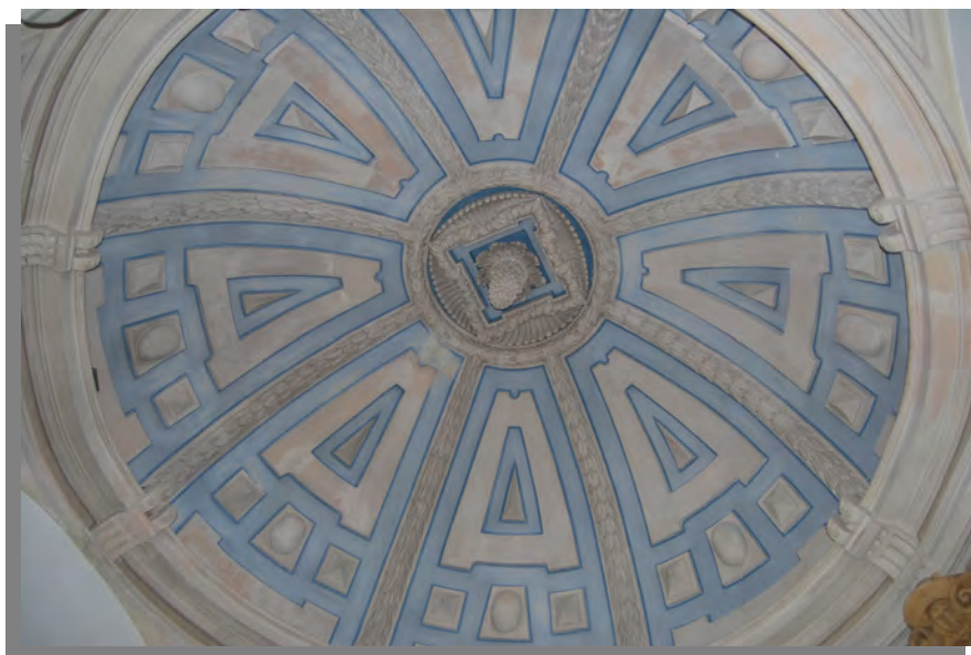
Figura 5.38-Detalle de la cúpula.(Fotografía: Rocío Velasco García).
