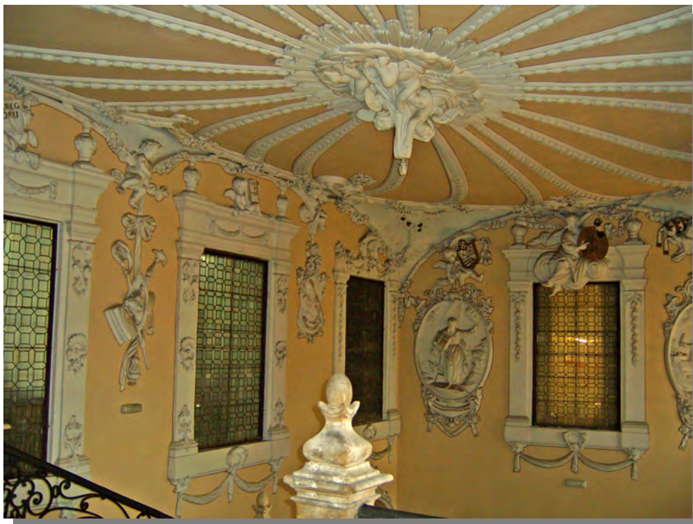
Figura 8.5-Cubierta de la escalera. (Fotografía: Rocío Velasco García).
