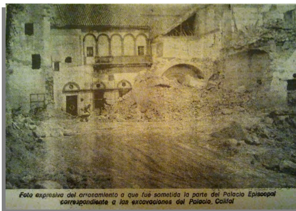
Figura 4.16-Vista de la fachada occidental que abre hoy día a los terrenos de la Biblioteca Pública Provincial. (Solano, “Demasiada generosidad”, Córdoba. La Voz de la Ciudad , 15 de octubre de 1976, p. 13).
