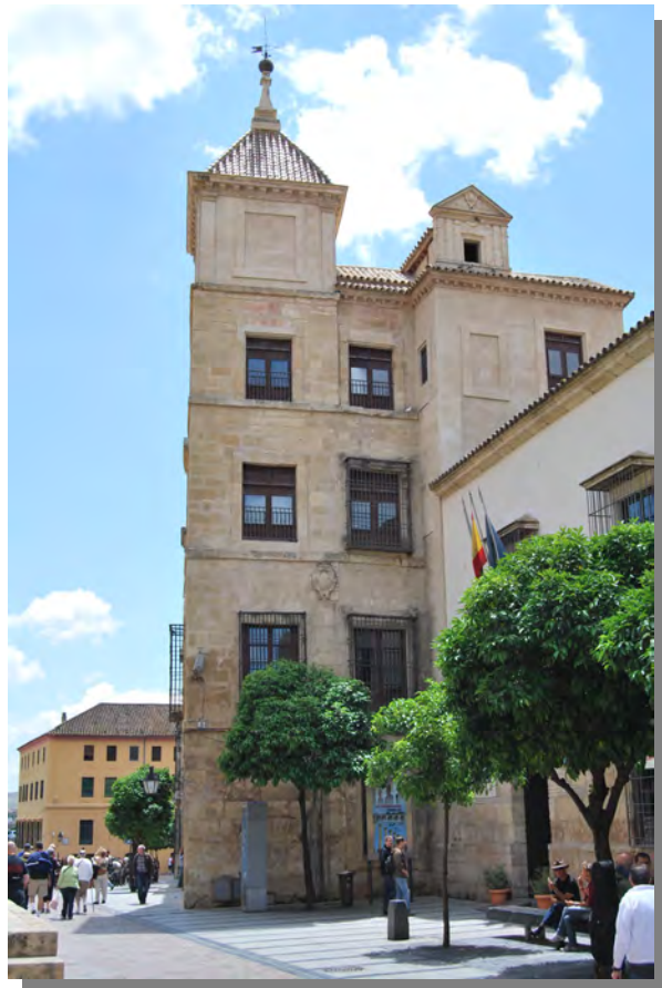
Figura 12.25-Torre norte. Estado actual. (Fotografía: Rocío Velasco García).
