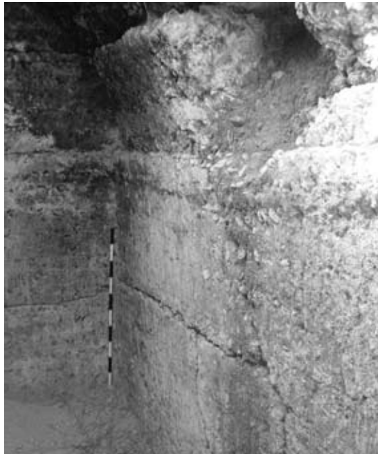
fig. 79 Interior de “El Silillo”, donde se aprecian las marcas de los encofrados utilizados para su construcción. Fuente: A. RUIZ.
