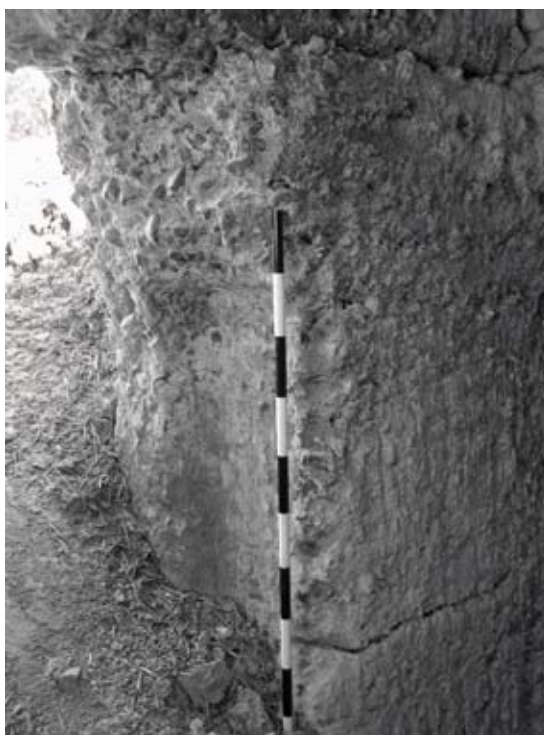
fig. 80 Vano de acceso a “El Silillo” visto desde el interior. Fuente: A. RUIZ.
