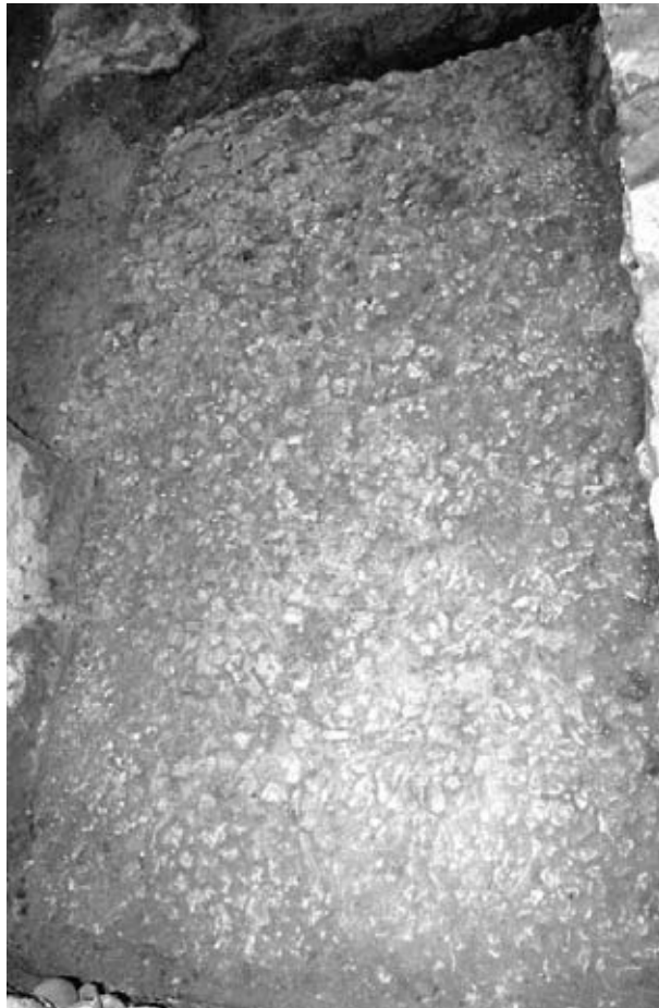
fig. 118 Cimentación de otro probable monumento funerario localizado en la Glorieta de Ibn-Zaydun. Fuente: MURILLO et alii , 2004.
