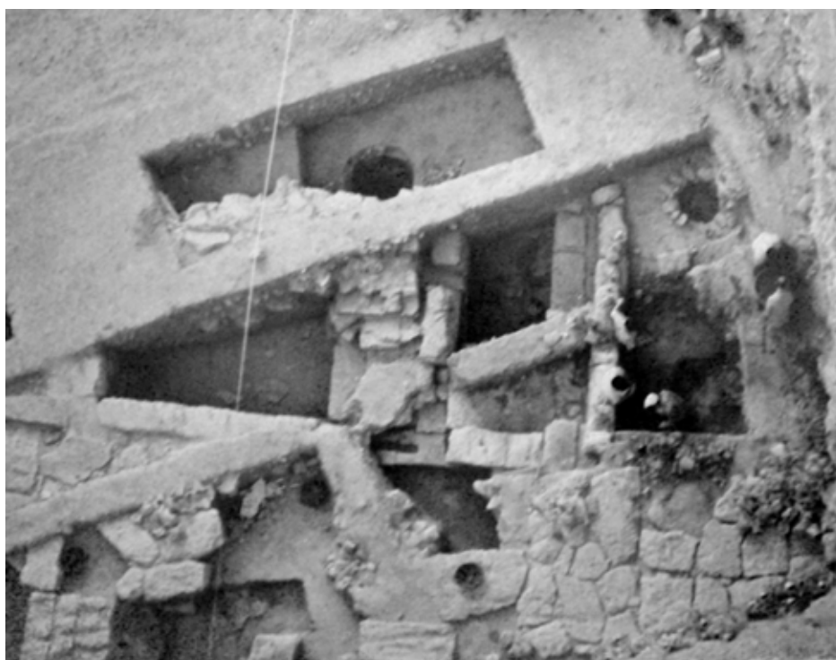
fig. 12 Restos de una calle porticada en Ronda de los Tejares, 6. Fuente: IBÁÑEZ, 1987 a.
