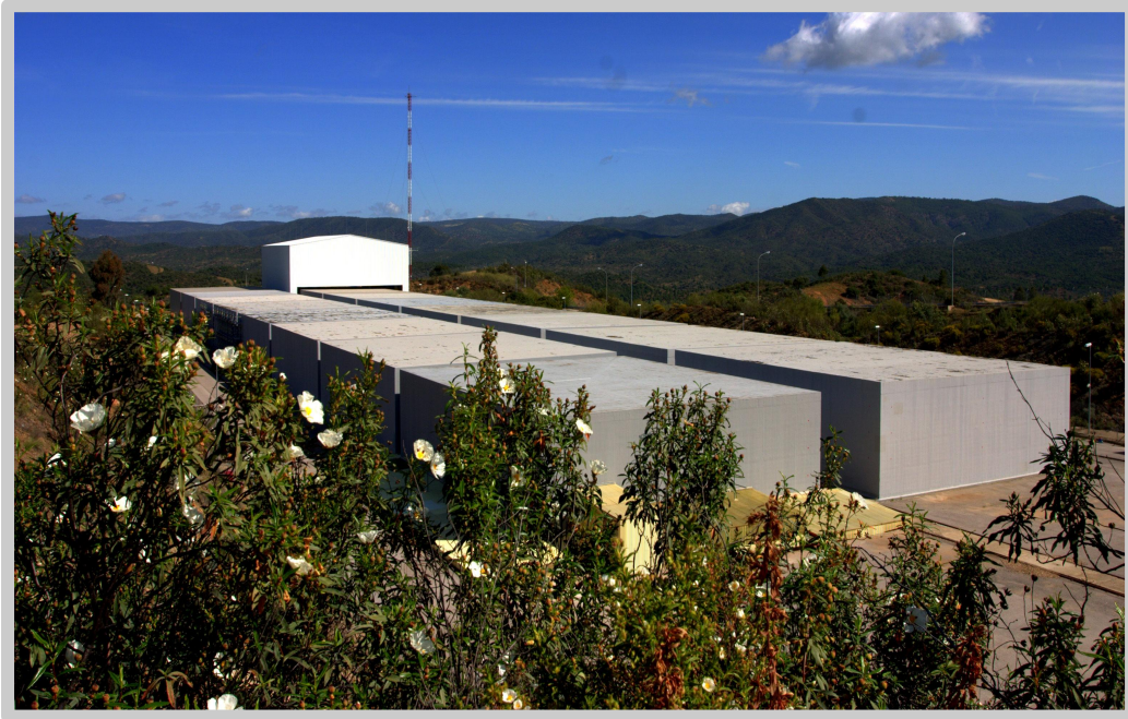
Figura 25: Vista de de las instalaciones del Almacén Centralizado de Residuos Radiactivos de Baja y Media Actividad El Cabril
