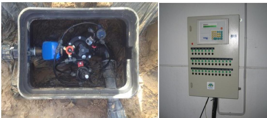
*Figura 6.2. Electrovalvula, contador y programador de riego.*
