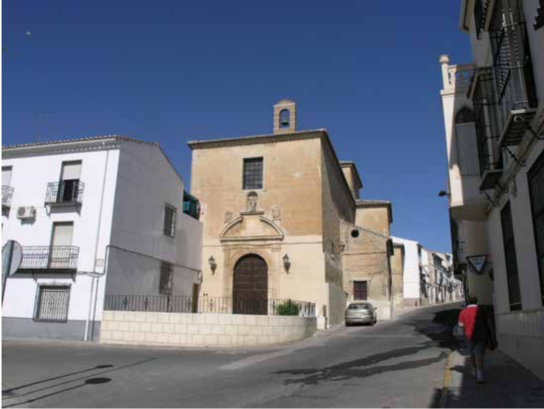
Patín del Convento y calle Velesar. Fachada de la iglesia del que fue Convento de San Nicolás de Tolentino, en el Prado.
