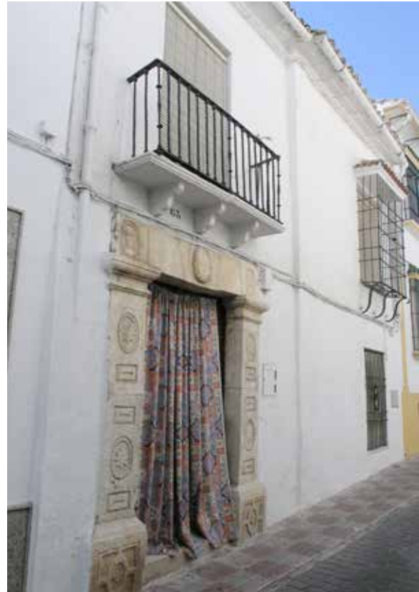
Calle Alta, casa nº 63, muy próxima ya al Hospital de Jesús Nazareno y a la confluencia con la calle Marbella.
