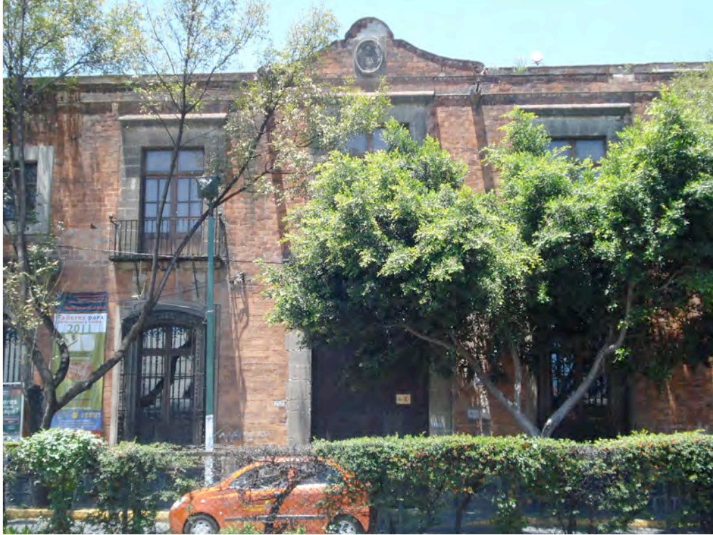
Fachada principal de la Casa de la Bola. Tacubaya, México, D. F. En el remate nótese el medallón con la efigie de Don Juan Suárez de Peralta labrado en cantera
