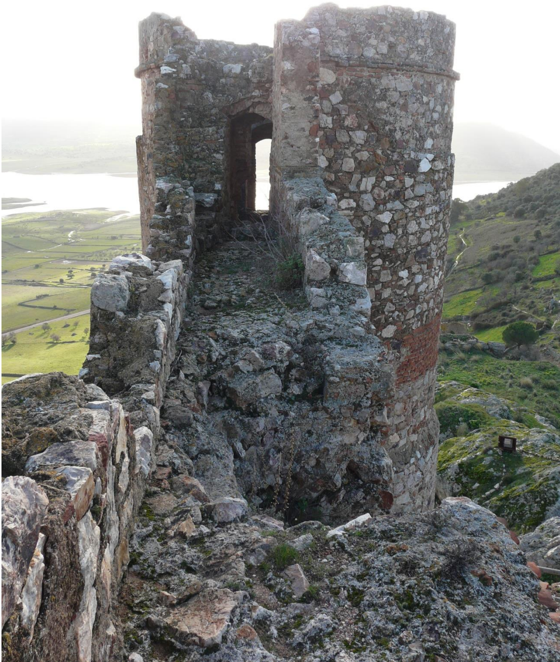
Ilustración 90: Torre G oeste, accediendo desde la torre principal. Fuente: Elaboración Propia, 2015
