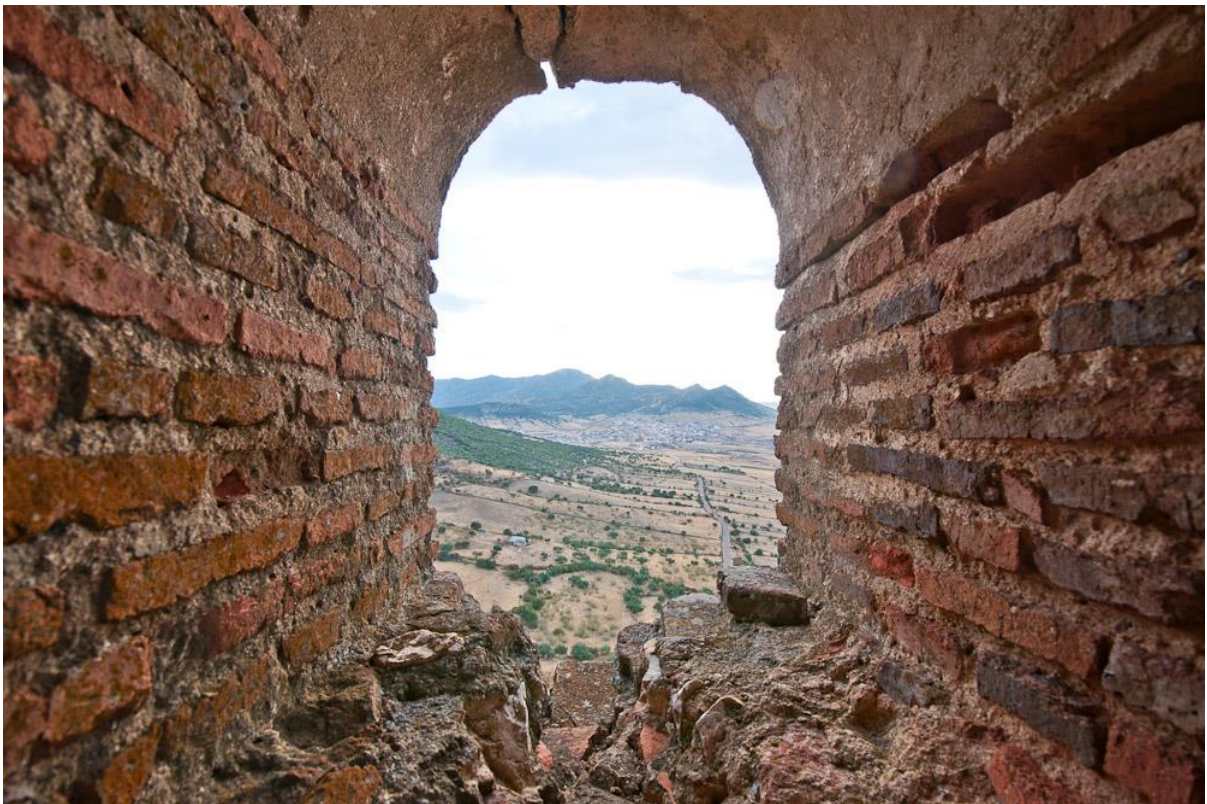
Ilustración 68: Ventana de la torre central orientada al Oeste, al fondo Peñalsordo. Fuente: Elaboración Propia, 2015
