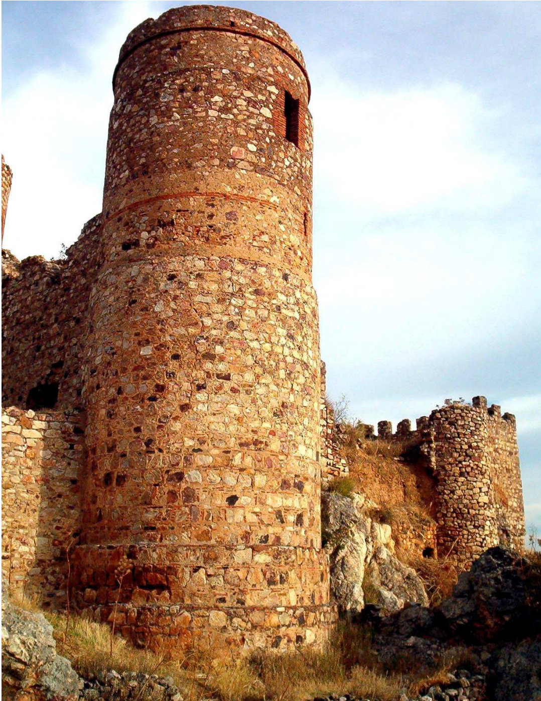
Ilustración 89: Torre G oeste, desde el exterior. Fuente: López, 2009
