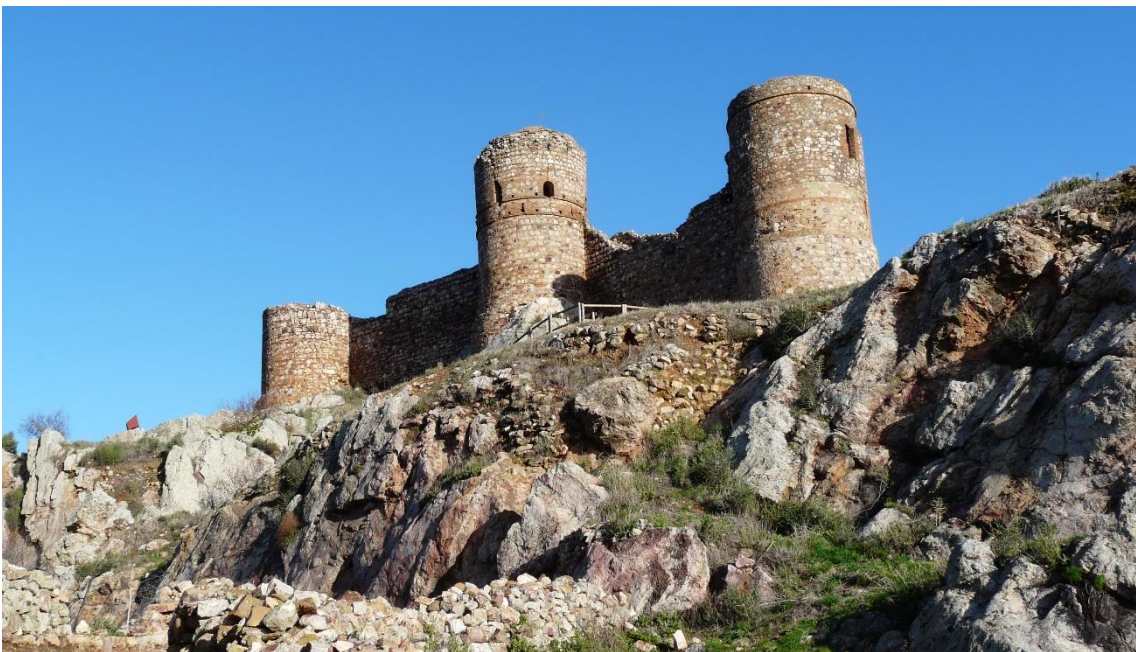
Ilustración 83: Vista de la muralla oeste y sus 3 torres. Fuente: Elaboración Propia, 2015
