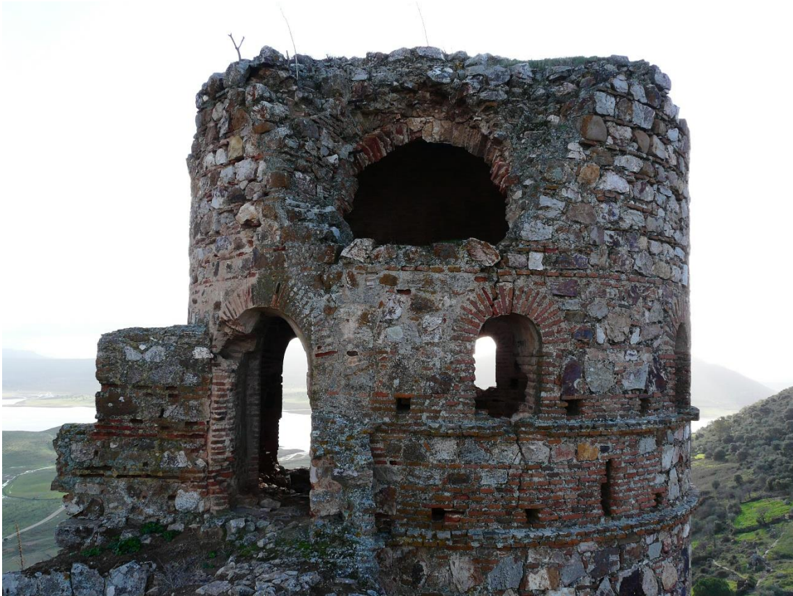
Ilustración 85: Torre principal vista desde la torre E. Fuente: Elaboración Propia, 2015
