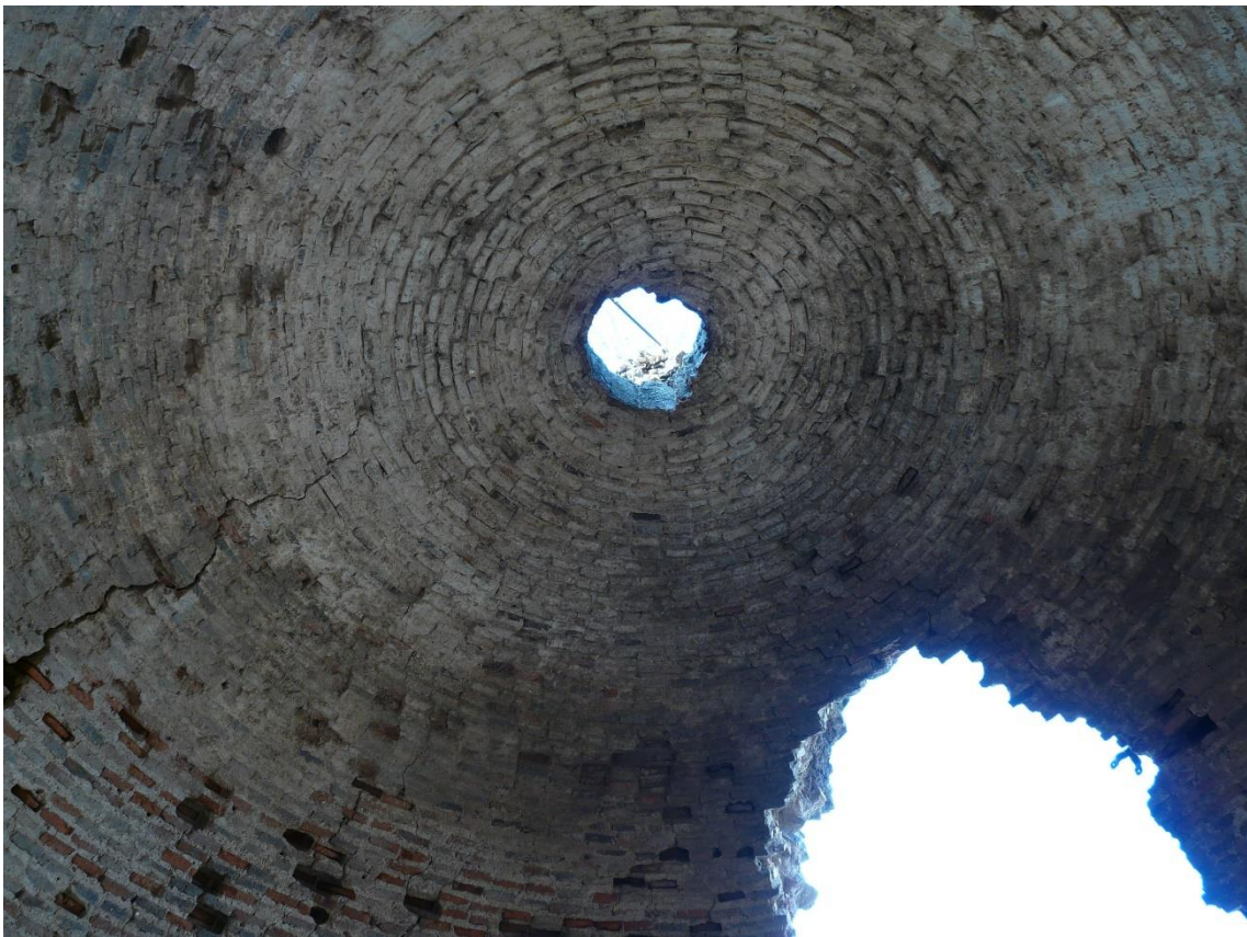
Ilustración 88: Bóveda desde el interior de la torre principal. Fuente: Elaboración Propia, 2015
