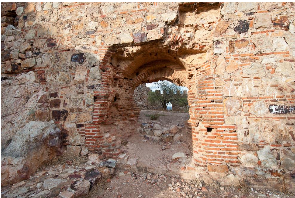
Ilustración 69: Puerta de acceso orientada al Sur-Oeste. Fuente: http://www.egrupos.net , 2014
