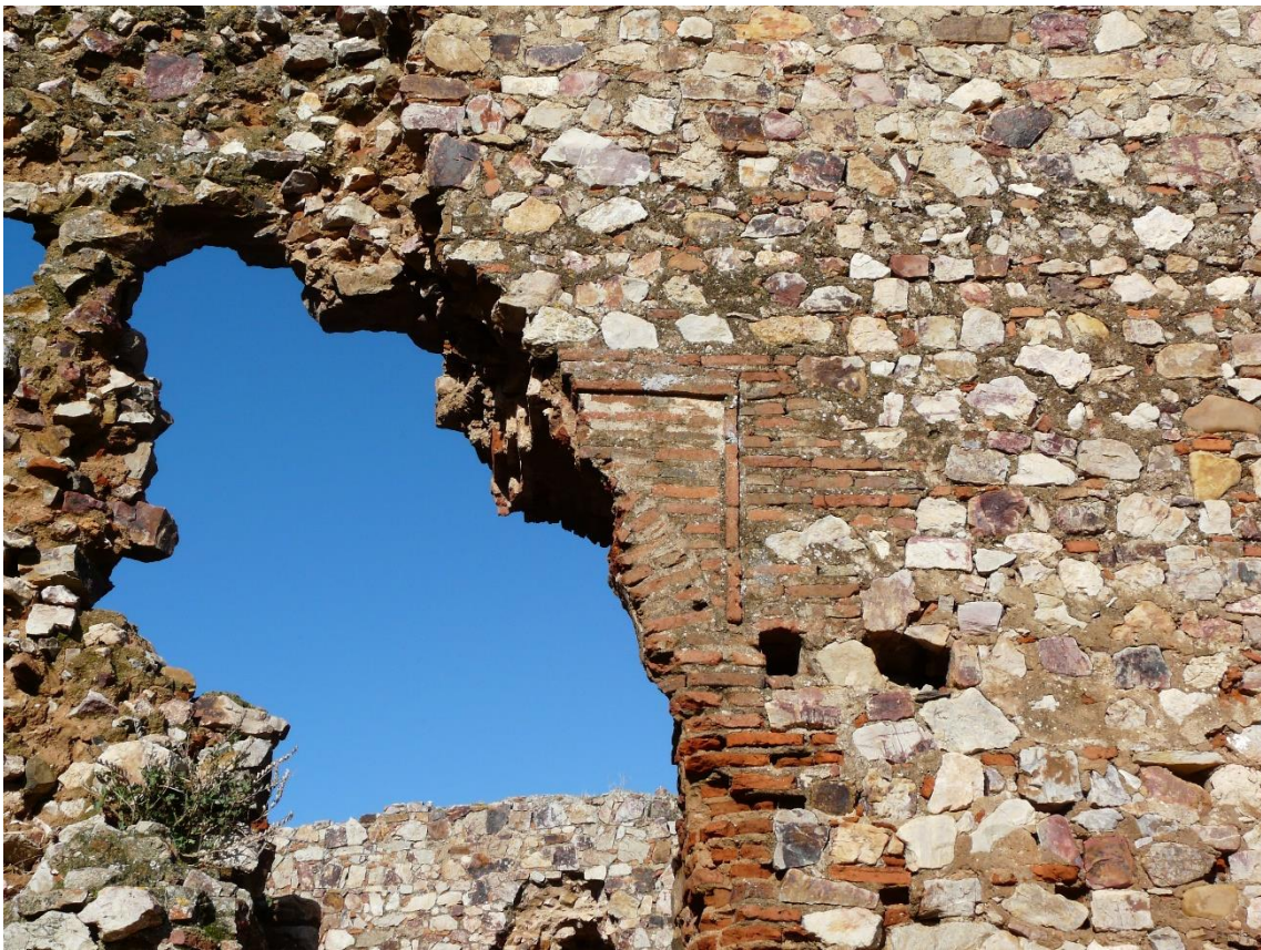
Ilustración 81: Puerta D, muro que separaba los patios interiores. Fuente: Elaboración Propia, 2015
