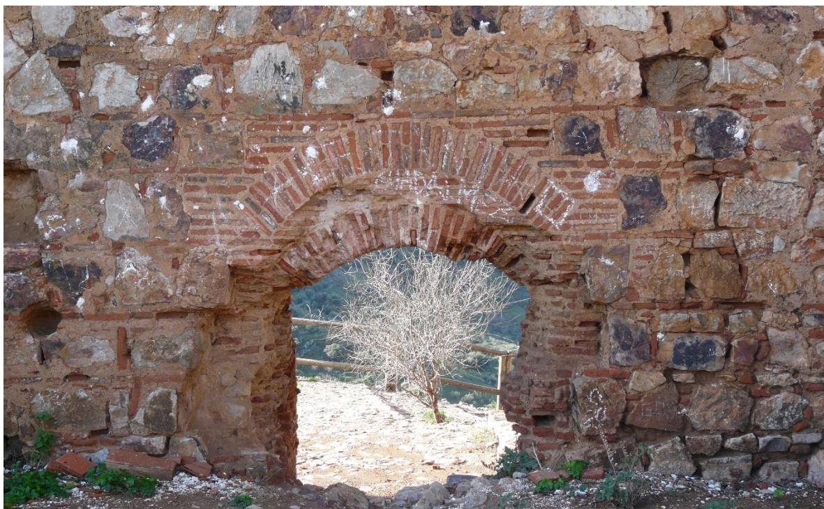
Ilustración 70: Misma puerta vista desde el interior del castillo. Fuente: Elaboración Propia, 2015
