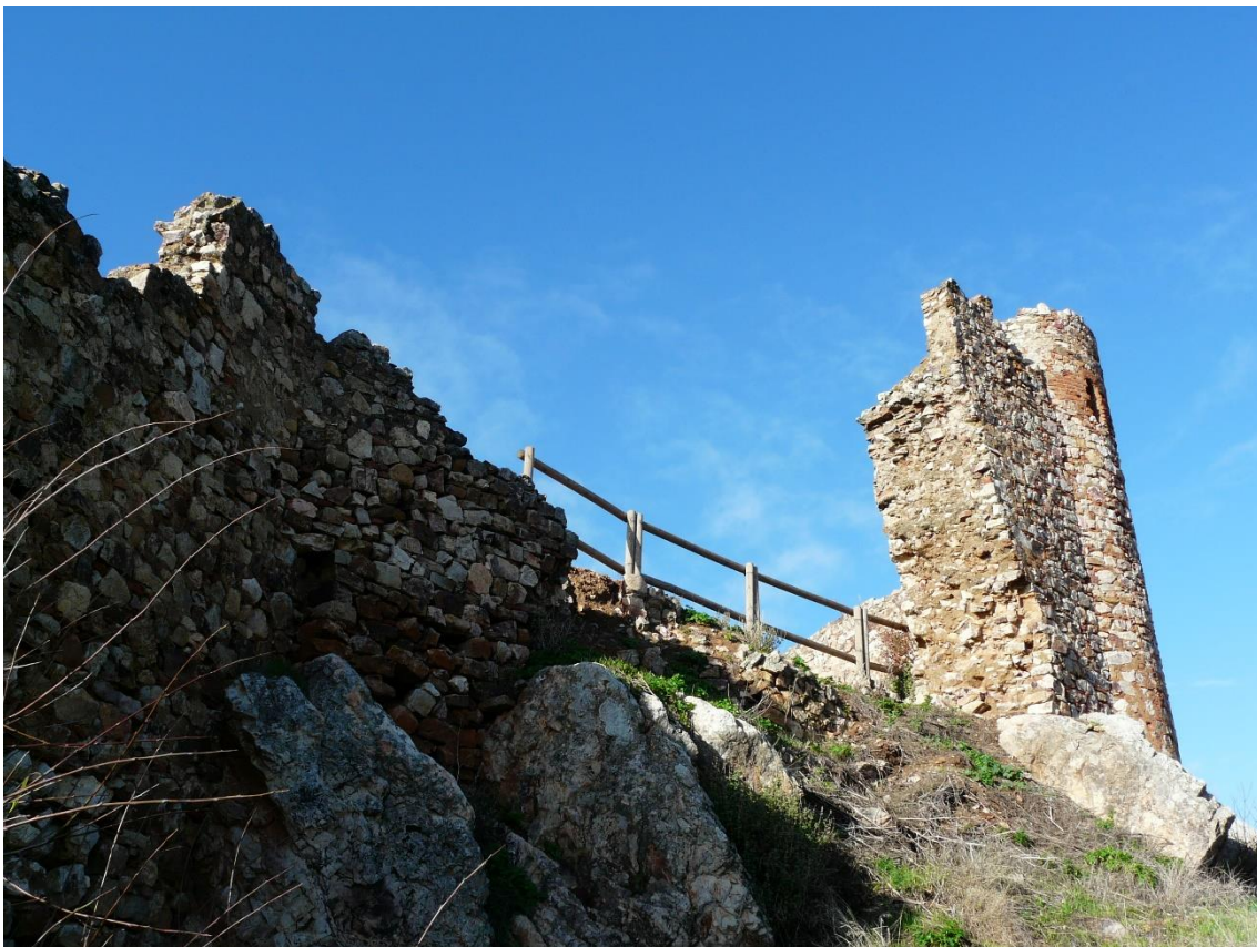
Ilustración 96: Torre F noroeste, vista desde el exterior. Fuente: Elaboración Propia, 2015
