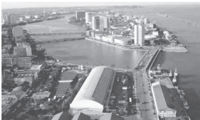
Fig. 5 e 6. Da esquerda para direita, cais e docas de Santa Rita, em 1967; na segunda foto, o Armazém 18, no antigo estacionamento construído após o aterro do Cais de Santa Rita.
