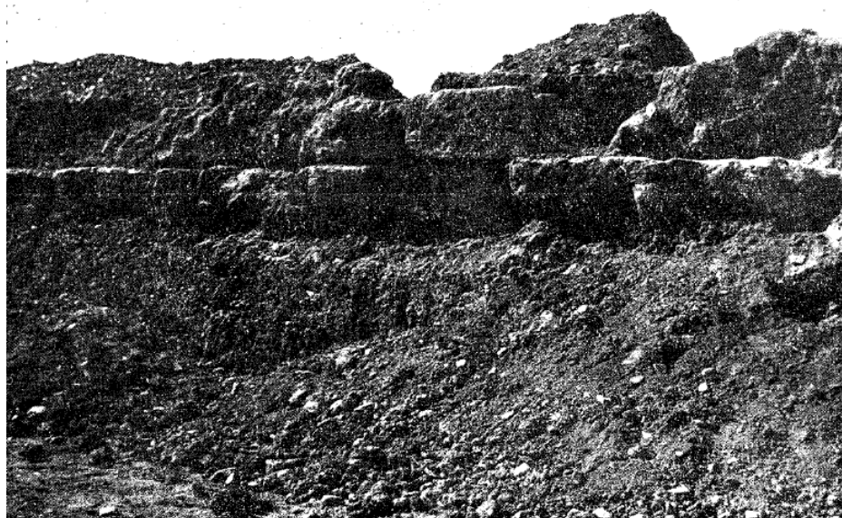
Fig. 104 y 105. Cortijo de Chinales: dos vistas del muro L-N-Q (SANTOS, 1955, lám. IX).
