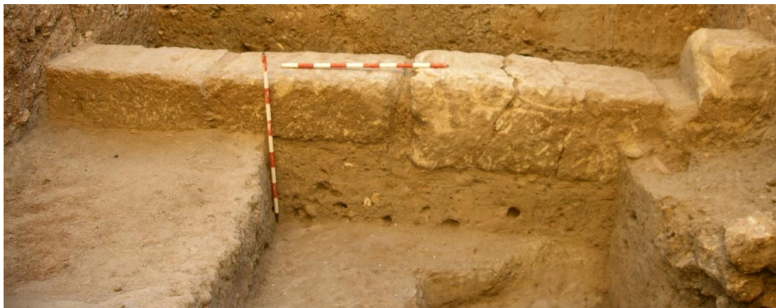
Fig. 124. Av. Ronda de Isasa 4: vista del muro U.E. 21, en el que se aprecian las fracturas y el buzamiento del paramento (GARCÍA BENAVENTE, OSUNA, 2005, lám. 25).
