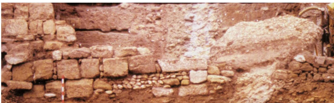
Fig. 221. Pl. de Jerónimo Páez 7: muro de contención de la segunda mitad del siglo VI - inicios VII (MONTERROSO, CEPILLO, 2002, fig. 1).
