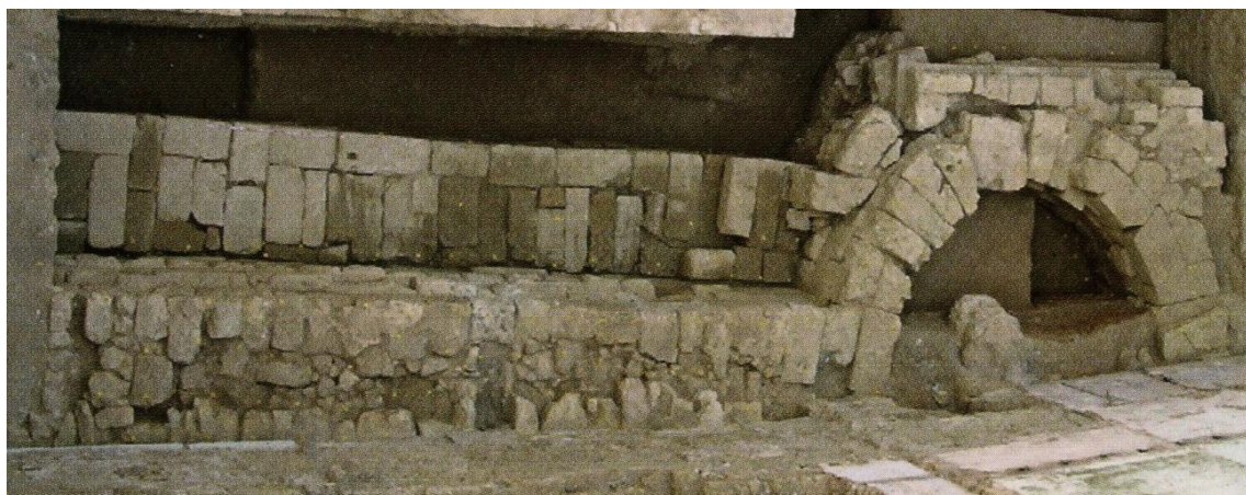
Fig. 8. Av. Ronda de los Tejares 11: vista cenital de un tramo de muralla. Se observa el muro exterior de contención del agger , la plataforma de sillares y el forro poligonal adosado a una torre semicircular (MOLINA MAHEDERO, 2009, lám.1).
