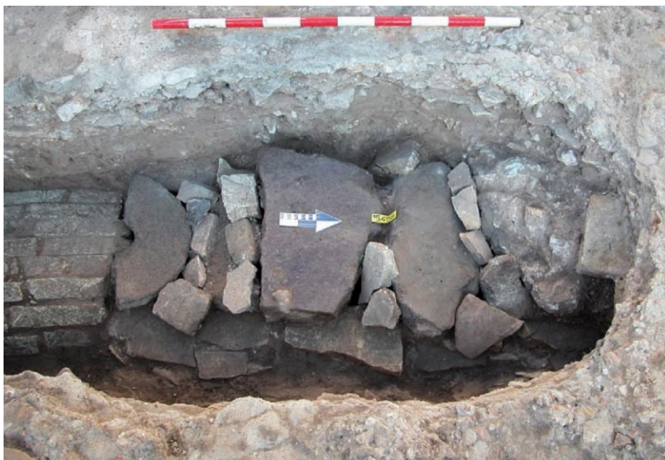
Fig. 302. Hispalis : reparación de la cubierta de una cloaca localizada en la pl. de la Encarnación (GONZÁLEZ ACUÑA, 2011b, fig. 20).
