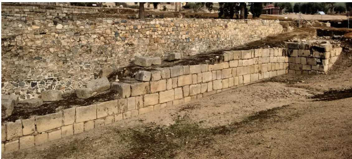
Fig. 294. Augusta Emerita : en primer plano, forro de sillares adosado a la cara externa de la muralla fundacional. Fotografía del autor.
