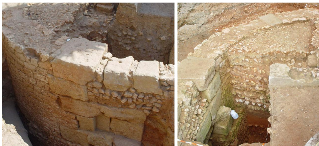
Fig. 213 y 214. Antiguo anfiteatro: detalles constructivos de la estructura semicircular oriental (MURILLO et alii, 2010a, fig. 121).
