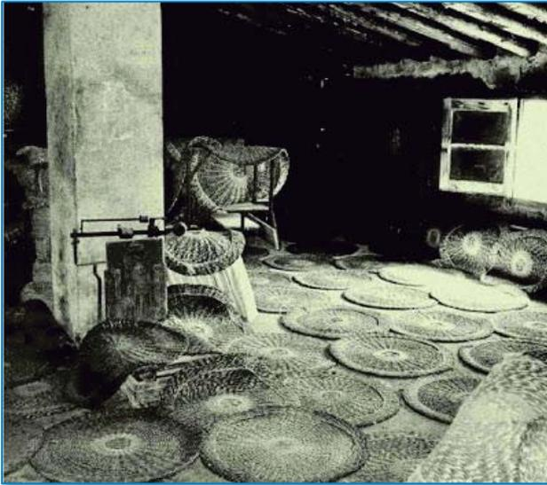
**Ilustración 86:** Imagen que muestra los capachos empleadas para el prensado del mastrujo. Almazara de Buera. Fuente: <http://www.aceitedelsomontano.org/>
