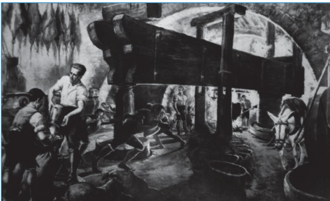
**Ilustración 26: Intensa actividad en una almazara con prensa de viga y quintal y molino de sangre durante la campaña de aceituna (López et al., 2012). Origen: Calendario de Pieralisi 1985-86.**
