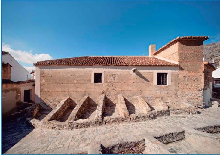
**Ilustración 52: Patio de trojes y nave de prensas de viga y quintal de la almazara de Laerillas en Nigüelas. Se observa la reconstrucción en tapial de sus muros y de mampostería y ladrillo la torre de contrapeso. (Zayas, 2017)**
