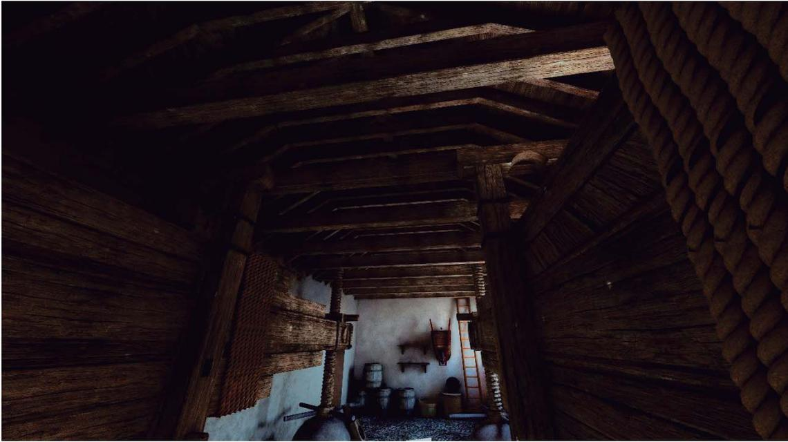
**Ilustración 183:** Solución de estructura de cubierta de par y nudillo.
