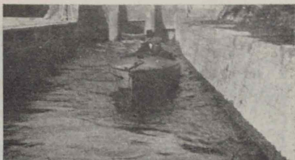
El canal en su origen.—Ancho medio 4 metros. Altura 2,50.—Capacidad 14 m.3 por segundo.
