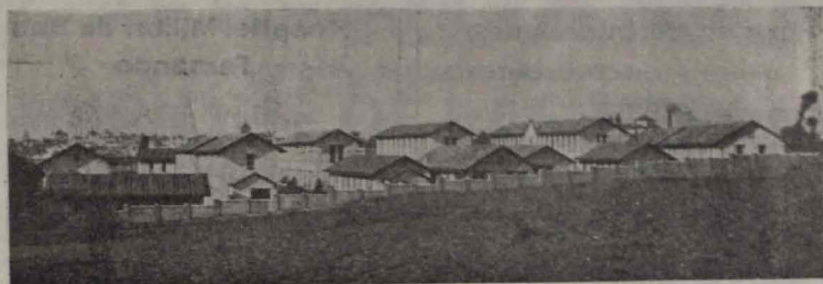
Hospital Militar de San Fernando, situado en la Fuensantilla
