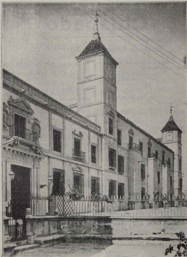
Fachada del Palacio Episcopal, en la calle de Torrijos
