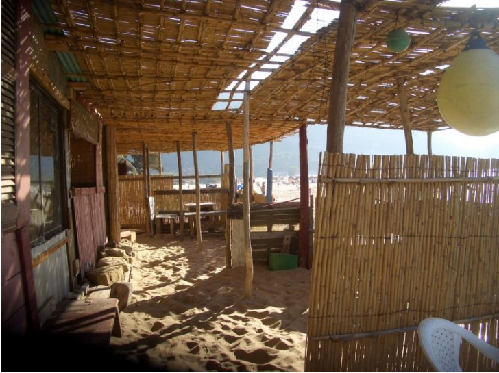
Terrasse de Chiringuito (restaurant) avec un toit pour ombrager, construite avec des matériaux naturels.
