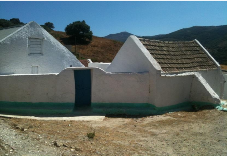
بنية من النوع التقليدي حيطانها مطلية بالأبيض لتجنب امتصاص الحرارة.
