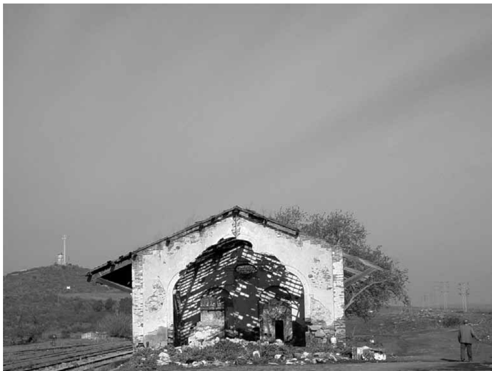
LÁM. 8: Muelle de la estación de Belmez en 2004 (hoy demolida). Fte.: fotografía del autor.
