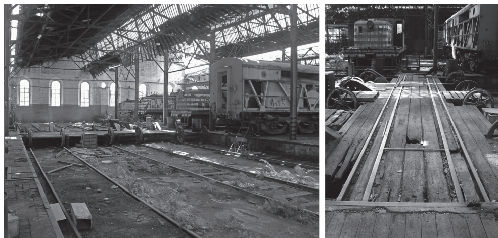
FIG. 6: Vista general del foso del pasador (izq.) y detalle de la pasarela o puente móvil (dcha.). El material rodante marca el punto en el que se encuentran las vías de inspección.
