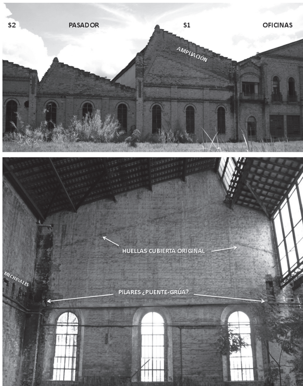
FIG. 8: Ampliación en altura de la nave N o S1: vistas de la fachada principal del edificio, al E (arriba), y del interior (abajo), donde también pueden distinguirse las huellas de un puente-grúa.
