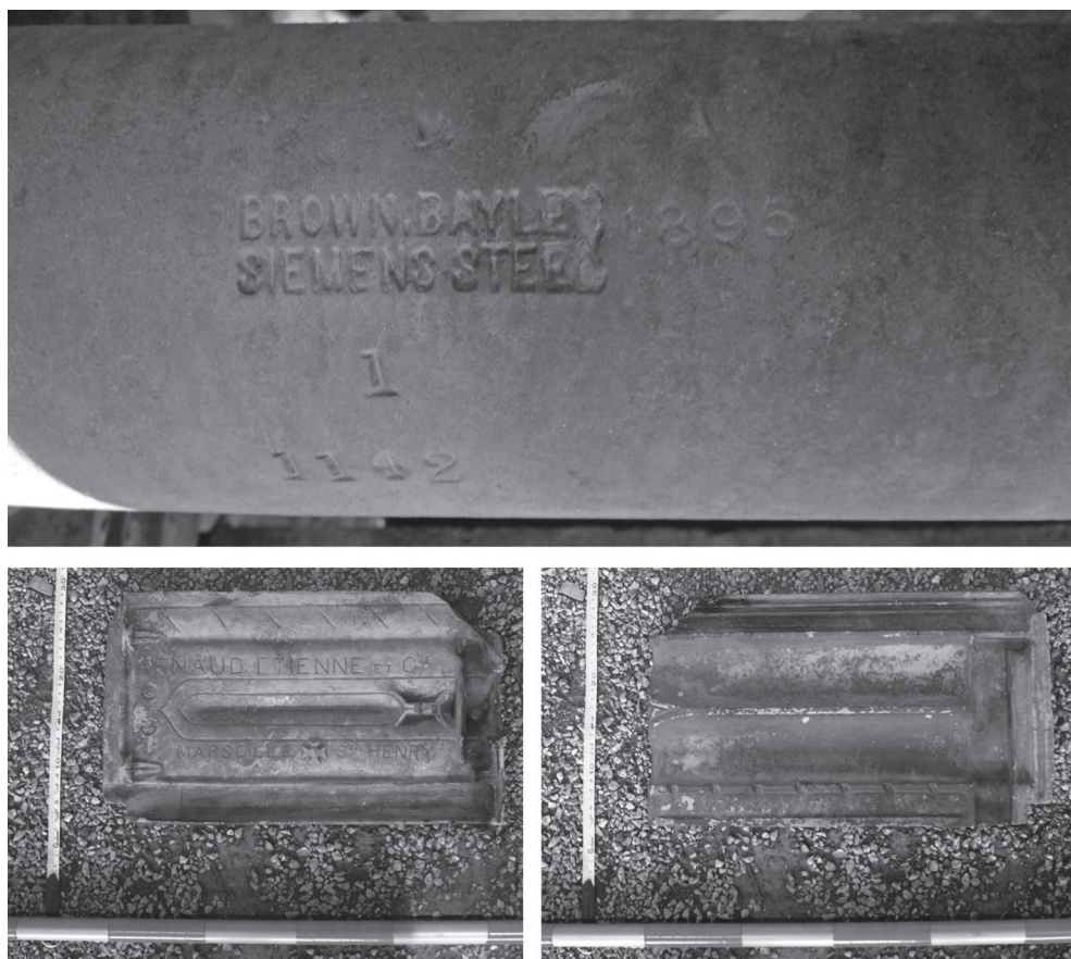
FIG. 10: Cultura material y transferencia de tecnología en los talleres de la Companhia Paulista. Arriba: inscripción en el eje NO del puente-móvil del pasador -Brown Bayle(y) Siemens Stee(l)-. Abajo: anverso y reverso de una teja de la nave P, con la leyenda “Arnaud Etienne et Cíe. / Marseille St. Henry”.
