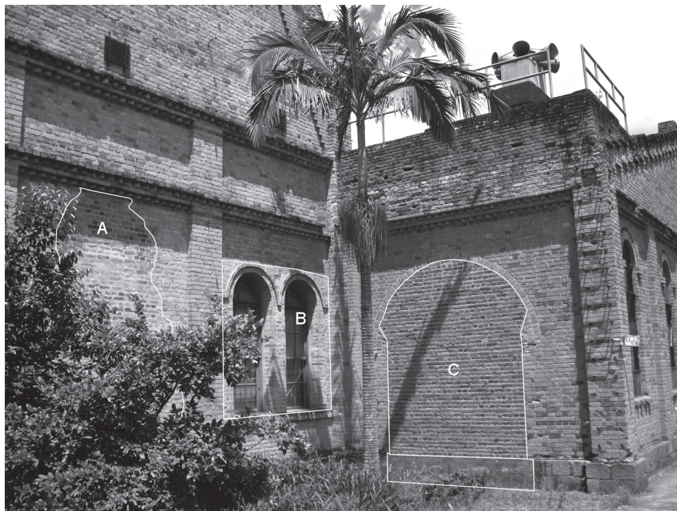
FIG. 9: Reformas en la fachada interior del complejo. El vano del tramo central de S1 ha sido eliminado (A), mientras que los laterales (septentrional a la izq. de la imagen, fuera de cuadro) se han desdoblado (B). El acceso N al pasador también aparece cegado (C).
