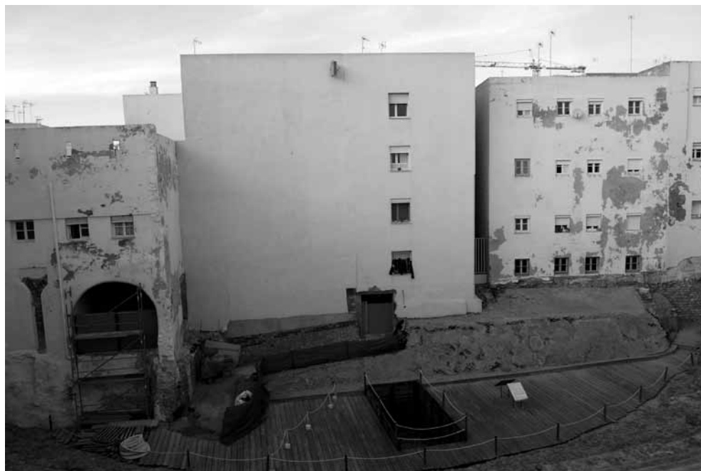
FIG. 11.- Vista de las edificaciones modernas erigidas sobre la orchestra y el frente escénico del teatro romano de Cádiz, cuya cimentación será objeto de consolidación en los próximos meses.
