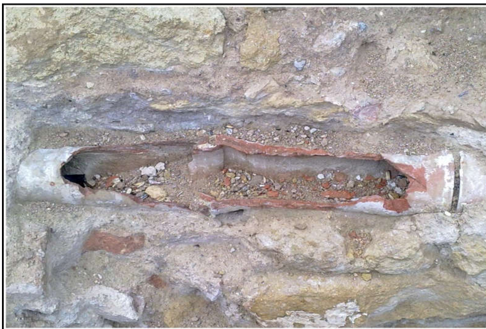
Foto (29). Ensamblaje de dos atanores.
