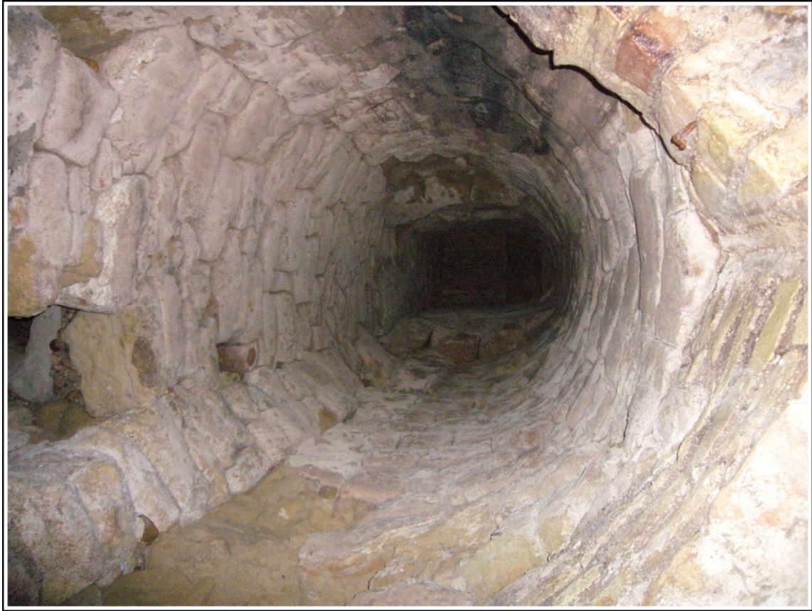
Foto (67). Encañado del pozo de la "Casa del Agua" en la calle Juan de Mena.
