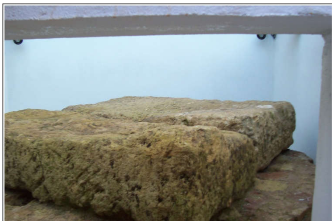
Foto (76). Pozo con sus tientos en el interior del edificio.
