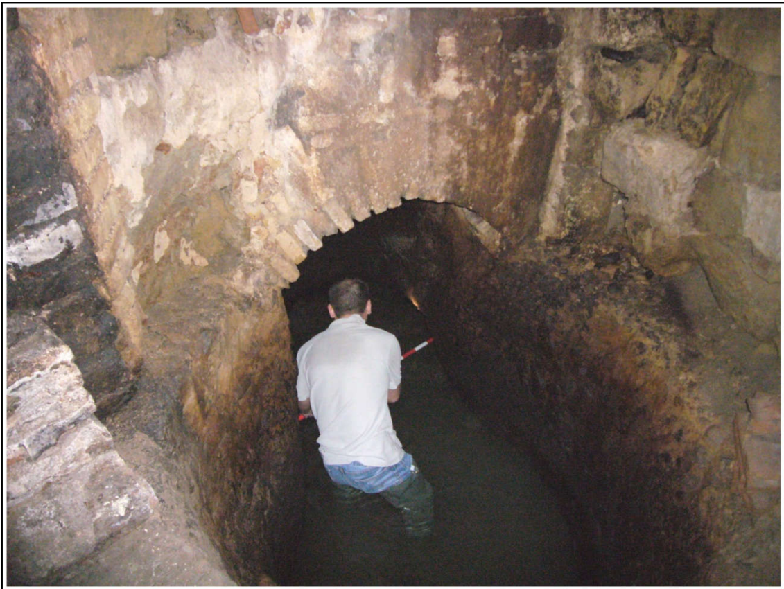
Foto (68). El autor midiendo las minas enfrentadas de captación correspondiente al pozo de la "Casa del Agua" en la calle Juan de Mena.
