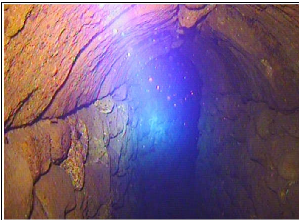
Foto (95). Galería del manantial a la altura de la urbanización los Girasoles en el barrio de Arroyo del Moro, con paredes y techo de mampostería (entrada localizada por Ángel Martos y por el autor en 2007).
