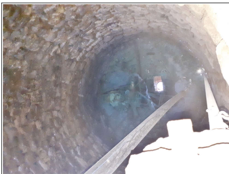
Foto (90). Pozo tipo noria de 12 m. de profundidad y 5 de diámetro para el riego de la huerta (convento Nuestra Señora de Gracia).
