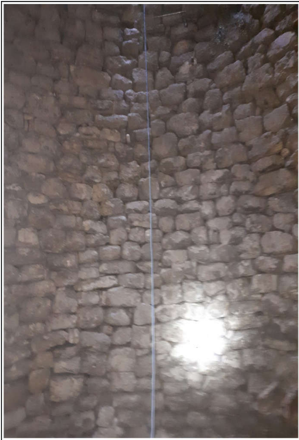
Foto (59). Encañado de mampostería.
