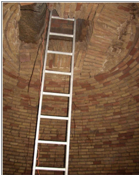
Foto (21). Aljibe de Caballerizas Reales.
