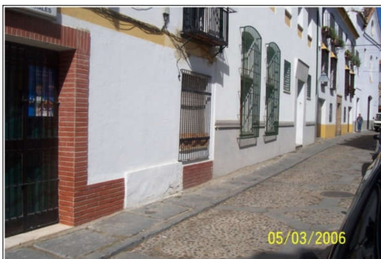
Foto (96). Muro floral de la farmacia de la calle San Basilio y la porción de pilón de su antigua fuente.
