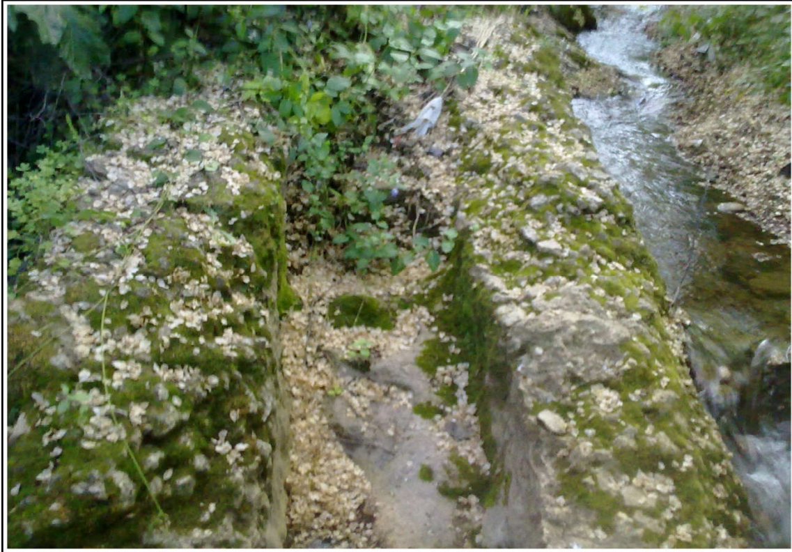
Foto (100). El acueducto a su paso por el arroyo del Moro antes de que fuera soterrado.
