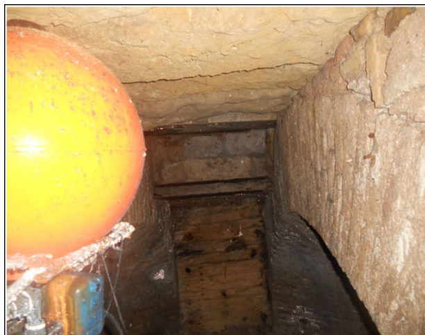
Foto (64). Arcadas del pozo.
