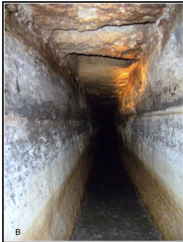
Foto (55). Foto (A) o conducción hacia la Puerta de Almodóvar: la foto (B) con dirección hacia los Jardines de la Victoria. Se aprecian lumbreras tapadas a lo largo de ella.
