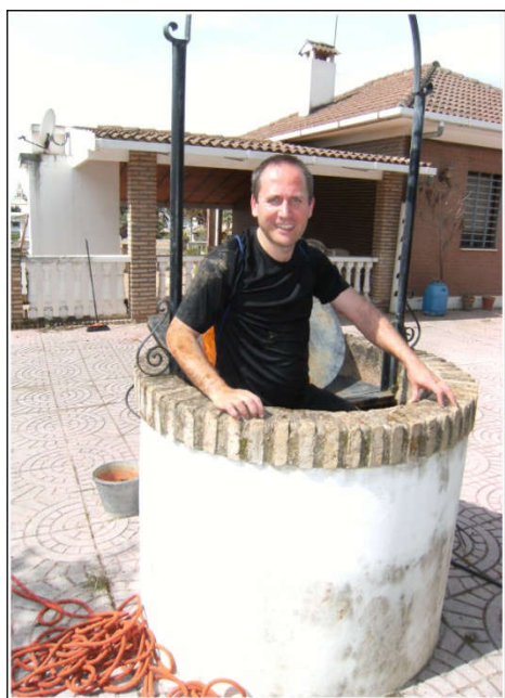
Foto 2. Entrada en una lumbrera.
