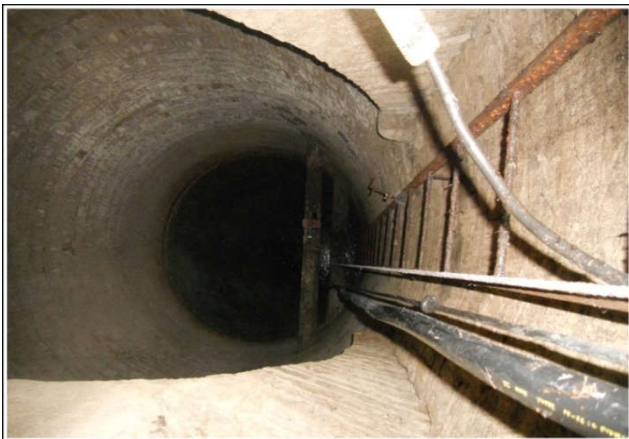
Foto (61). Encañado del pozo.
