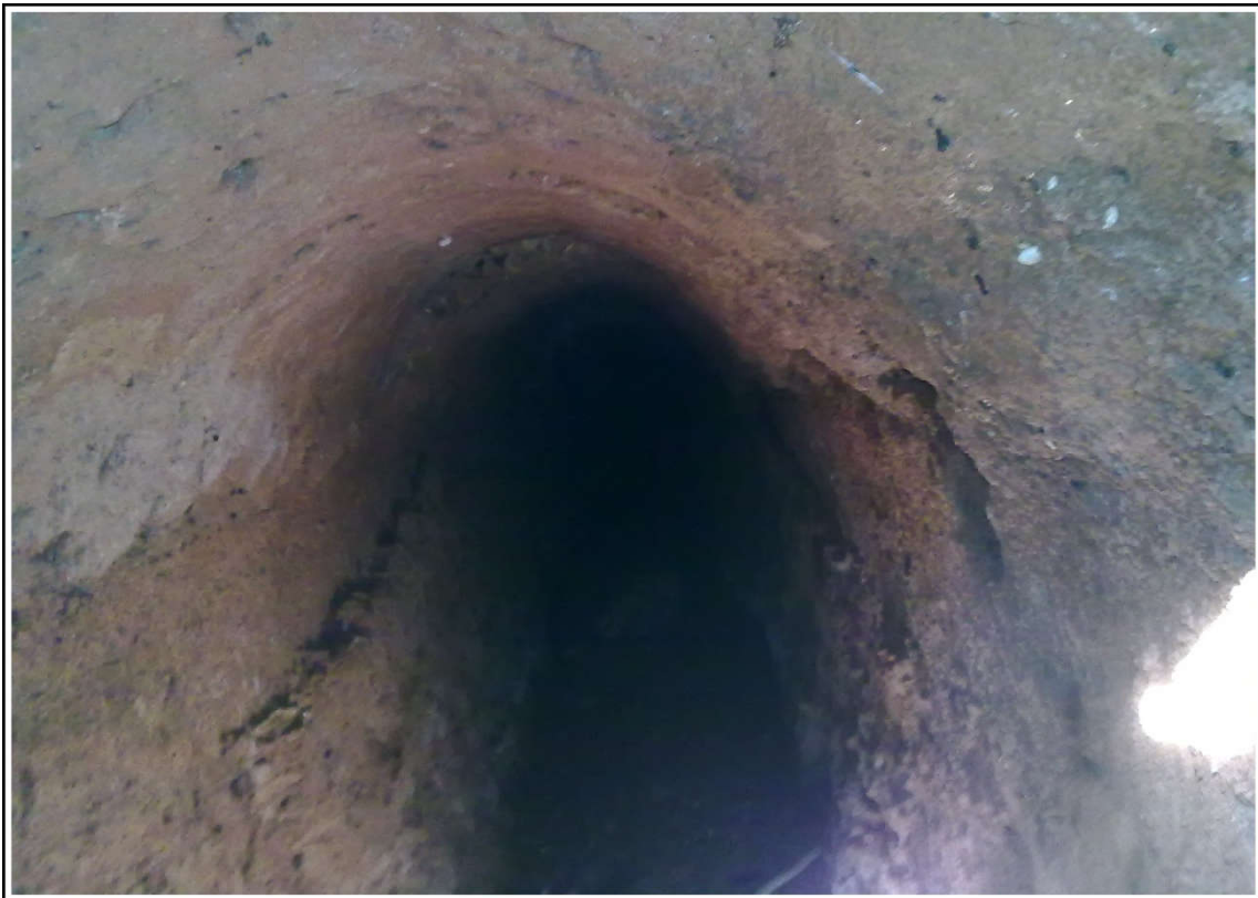
Foto (101). Interior del acueducto.
