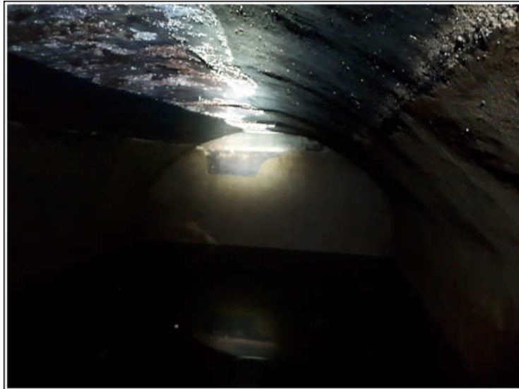
Foto (85). Depósito subterráneo del ex convento de Santa Isabel de los Ángeles al que se descendió con equipo de progresión.
