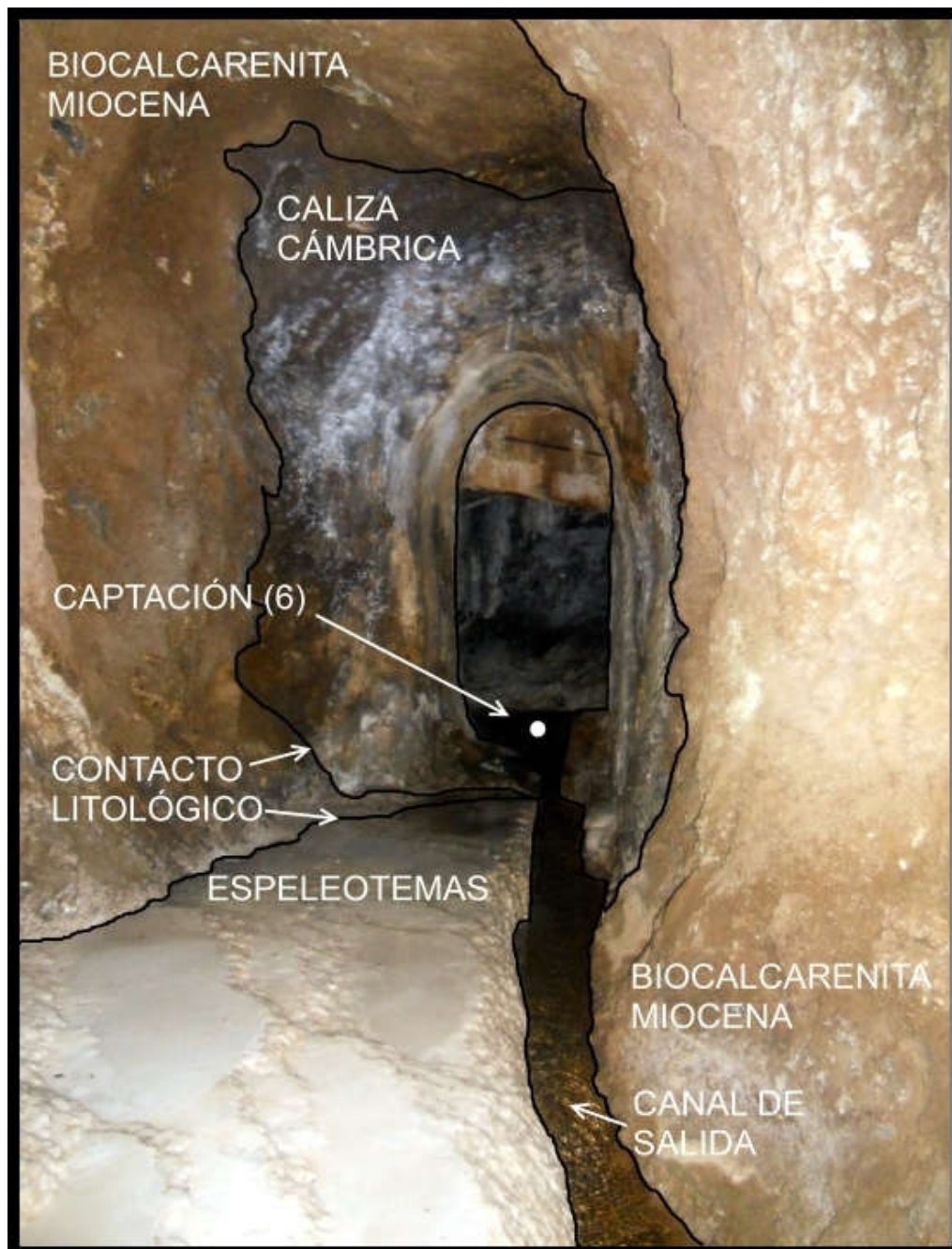
Foto (77). Elementos litológicos y morfológicos de la mina de Huertas Unidas. (GAMERO et al. , 2017).
