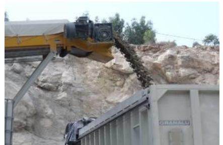
Figura 24. Carga sobre camión de HSC-AR
