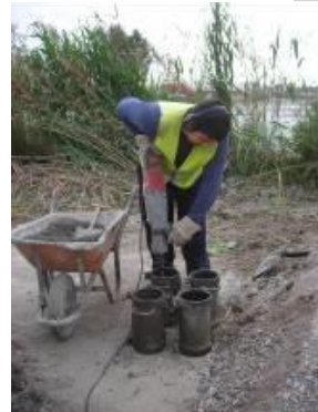
Figura 28. Fabricación probetas testigo en obra.
