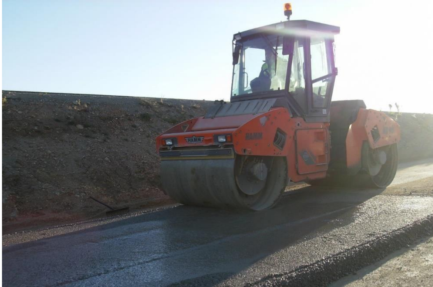
Figura 39 Compactación de áridos tratados con cemento
