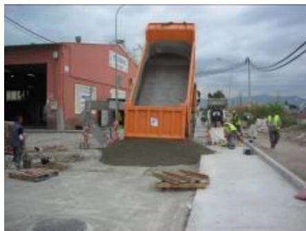
Figura 27. Vertido HSC-AR en la obra
