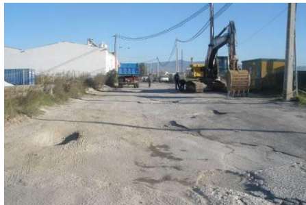
Figura 25. Estado inicial de la vía
