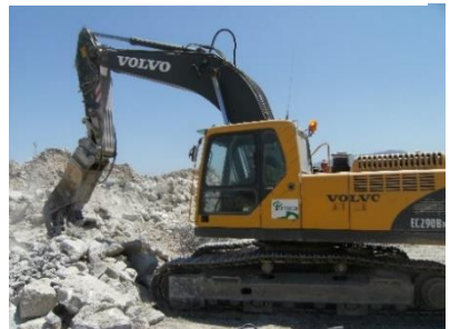
Figura 10 Tratamiento previo del residuo con pinza demoledora
