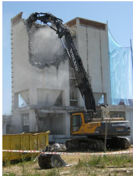
Figura 3 Demolición. Generación de RCD.
