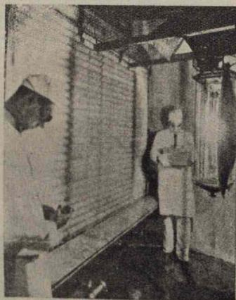
Irradiación de la leche con un arco voltaico, cuya intensidad se mide con un indicador de rayos ultravioletados utilizado en el proceso mediante el cual se inocula la vitamina D a la leche.
