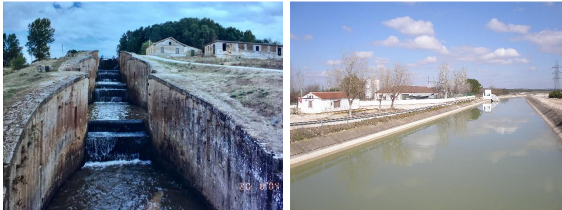
Figura 2. Canal de Castilla (dcha., fotografía de JM Abolafio) y canal del Genil-Cabra (Córdoba) con estación de bombeo.
