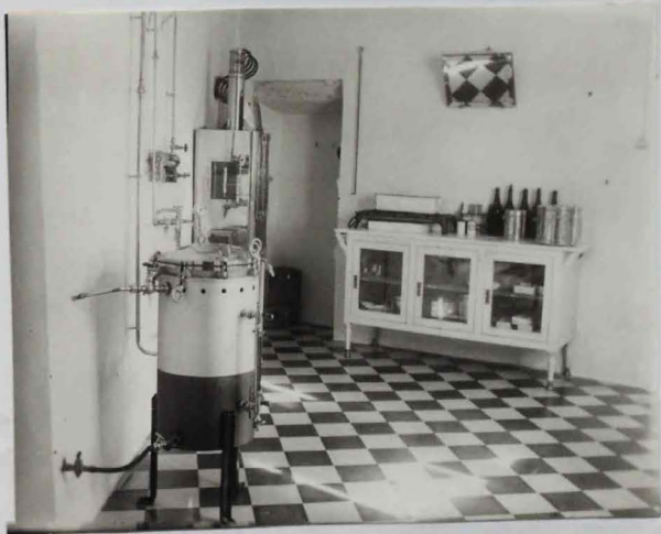
Lavadero y sala del Autoclave.
