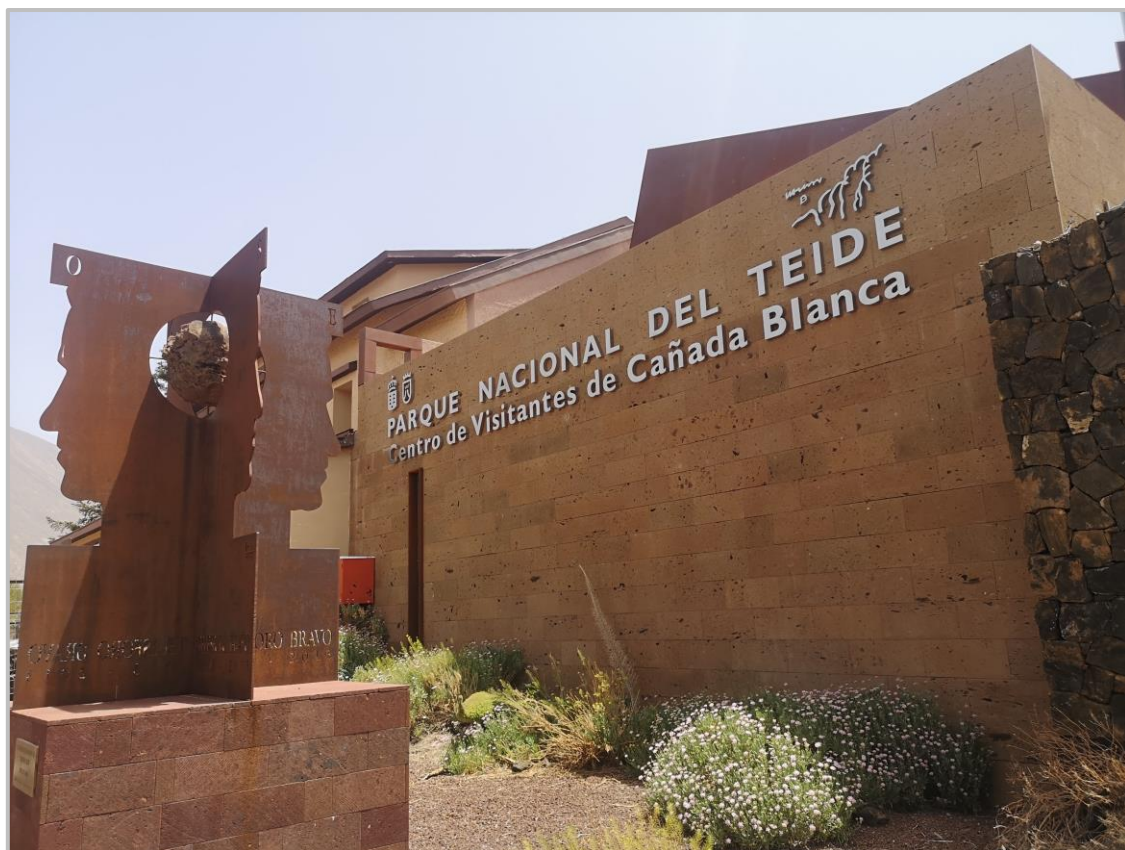
Fig. 7: Estado actual del proyecto en ejecución del Centro de Visitantes de Cañada Blanca en las Cañadas del Teide. Foto: GGM.
