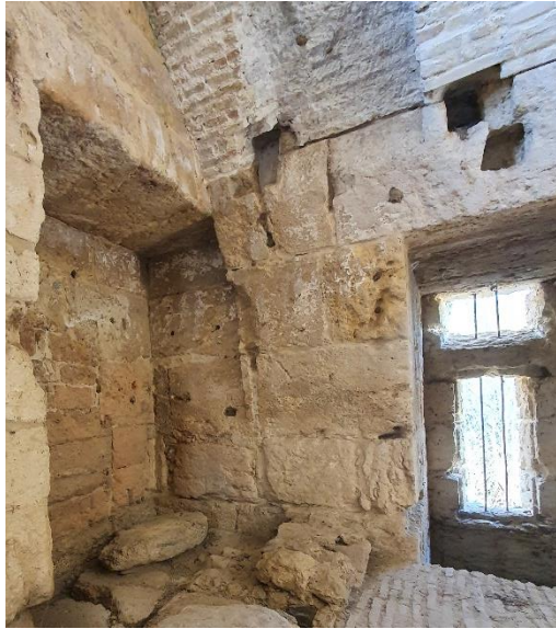
Ilustración 18. Vista del último vano, rematado en forma adintelada del año 1565. Fotografía de autoría propia.
