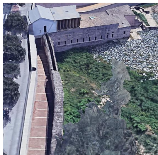
Ilustración 9. Rampa de acceso original a vista de pájaro desde el exterior. Fuente: Google Earth
