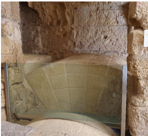
Ilustración 10. Bóveda de la compuerta del canal principal. Fotografía de autoría propia.
