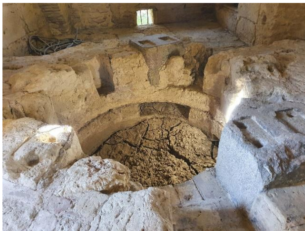
Ilustración 34. Pozuelo de la primera crujía colmatado con sedimentos fluviales. Fotografía de autoría propia.
