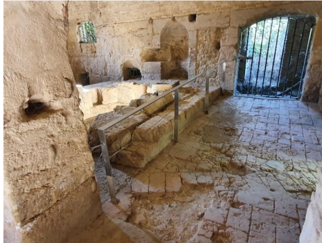
Ilustración 29. Tercera crujía: detalle del pavimento, hornacina y puerta de acceso a la zona de “los patios colorados”.
