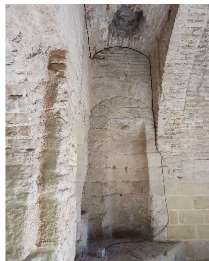
Ilustración 25. Chimenea. Fotografía de autoría propia.
