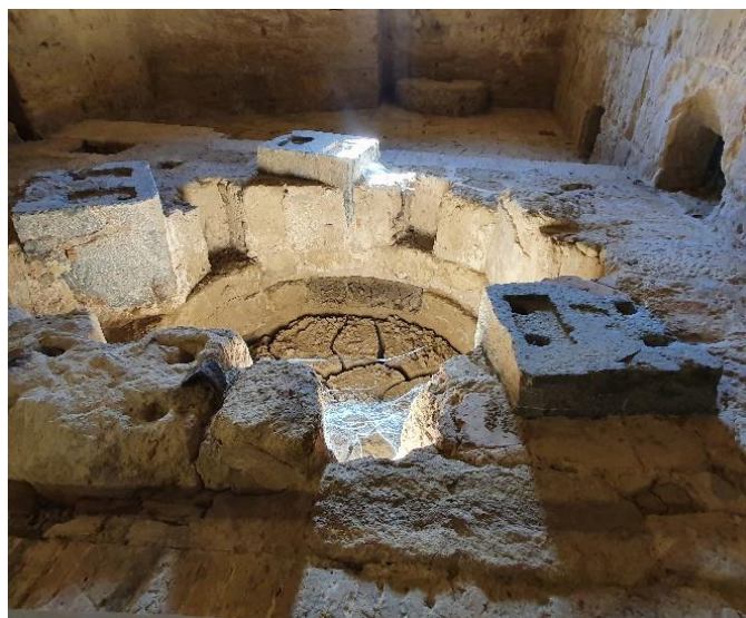
Ilustración 28. Detalle de pozuelo donde iría instalada la segunda turbina hidráulica y bloques de piedra sustentantes de las piedras de moler. Fotografía de autoría propia.
