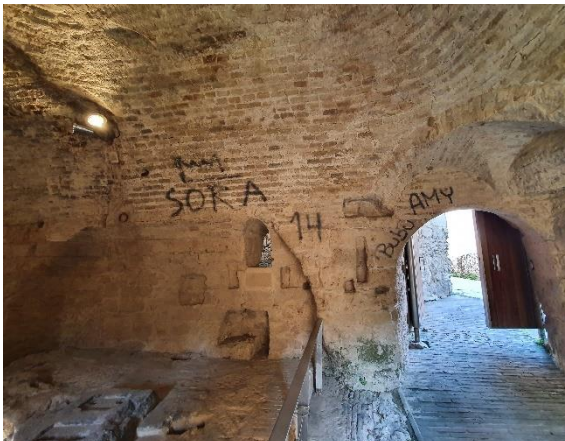
Ilustración 34. Fotografía de la primera crujía de batanes en diciembre de 2021. Se pueden observar varias pintadas en su muro anejo a la sala de molienda. Fotografía de autoría propia.
