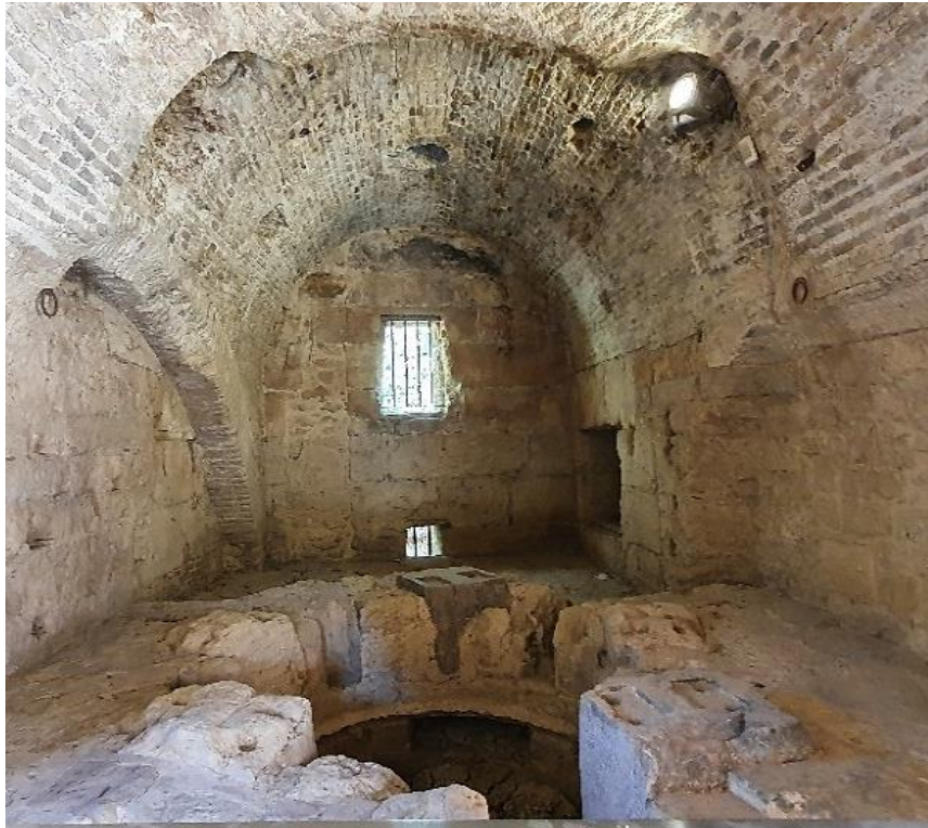
Ilustración 24. Vista con detalle de cerca de pozuelo y bóveda de la primera crujía. Fotografía de autoría propia.
