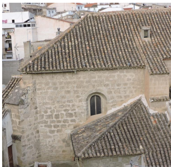
Fig. 6. Capilla. Vista desde el exterior.
