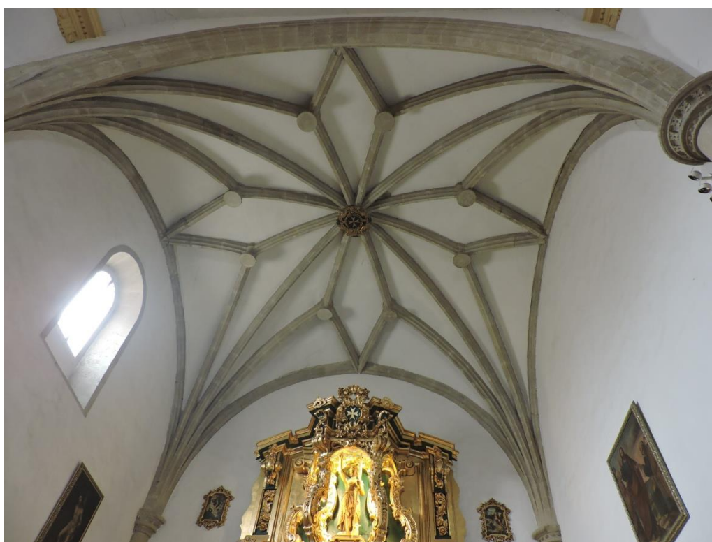
Fig. 5. Bóveda estrellada de la capilla mayor.
