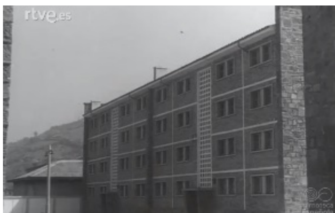
Fig. 46. NOT-N-603A, 1954. Viviendas en Usera.
