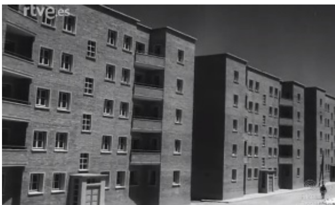
Fig. 45. NOT-N-571B, 1953. Viviendas en Campomanes.
