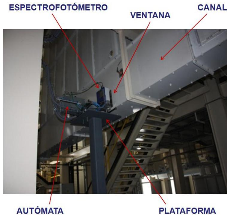
**Figura 3: vista general de la instalación del espectrofotómetro**
