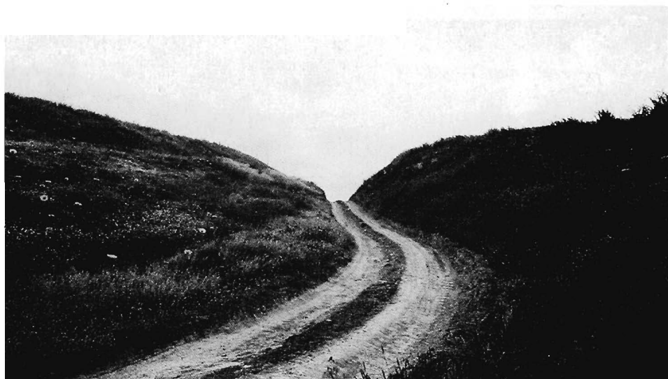
Fig. 8.- Encajonamiento del camino con el fin de aminorar la pendiente existente (sector 3.º)
