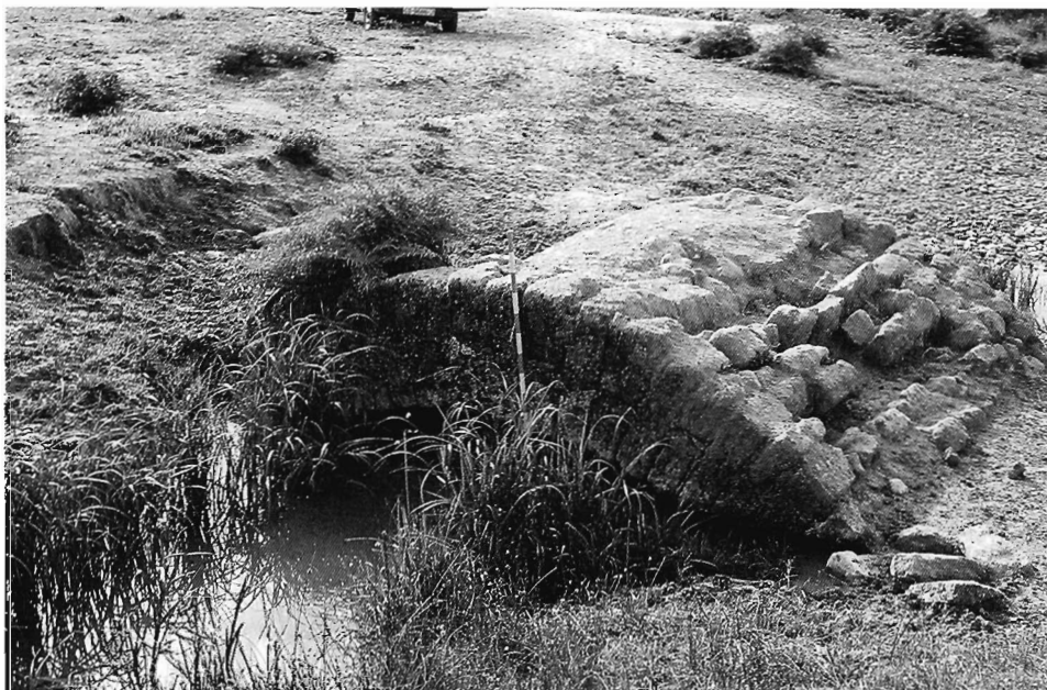
Fig. 12.- Puente sobre el arroyo de Fontalba.
