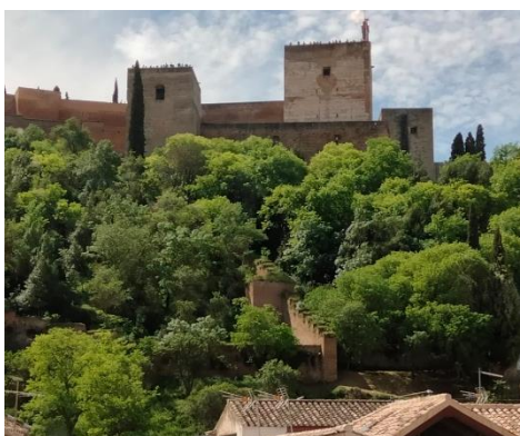
Fig. 3. Paño de muralla que une el bien analizado con la Puertas de las Armas en época nazarí. Fotografía de detalle tomada desde Casa de Zafra. Elaboración propia (2022).
