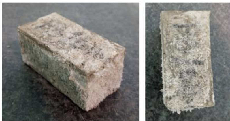
Figura 15. Signos de eflorescencia en geopolímeros con 14M
