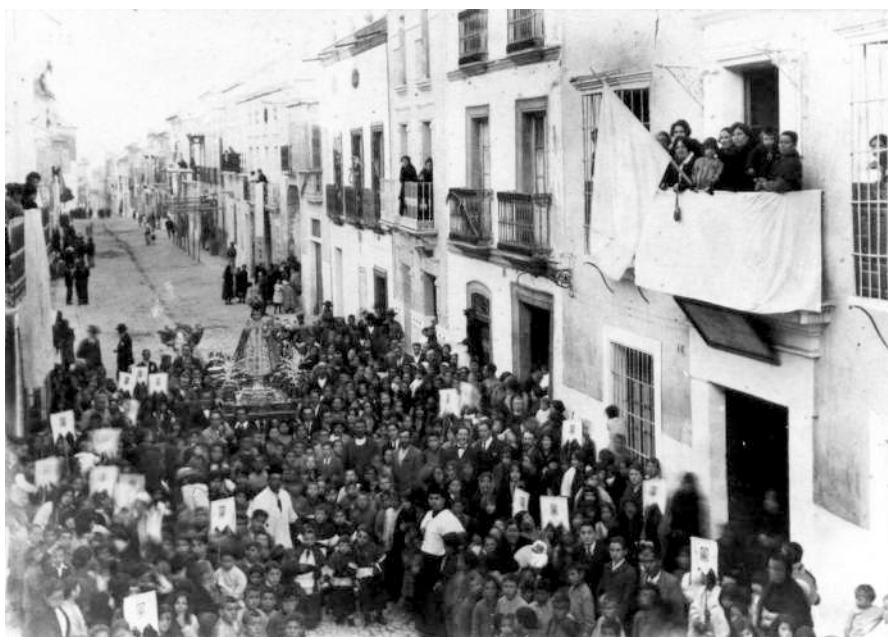
Fig. 9. Procesión del Niño Jesús de Praga (ca. 1921) –detalle–. Al fondo, a la derecha, obsérvese la andamiada en la fachada principal del inmueble. Fuente: Archivo Municipal de Aguilar.
