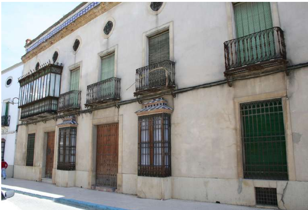
Fig. 11. Fachada de la casa-palacio Aragón. Fotografía: Fundación Arquitectura Contemporánea – Francisco Daroca Bruño. Fuente: https://arquitecturacontemporanea.org [Fecha de consulta: 13 junio 2022].
