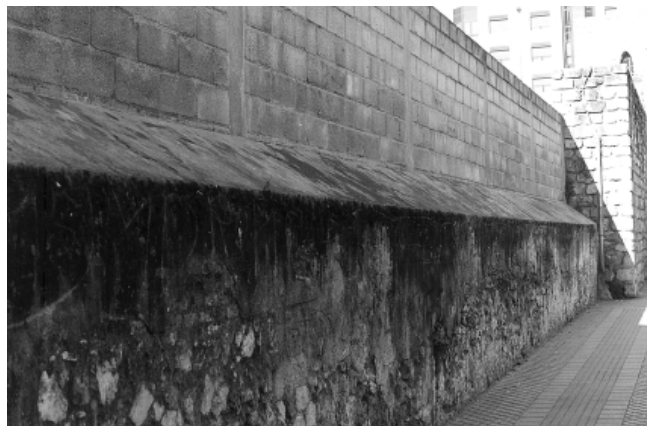
LÁM. 1. Trazado de la muralla en la Avda. de las Ollerías. En primer término, aspecto que presenta. Al fondo, el tramo restaurado en la década de los 80.
