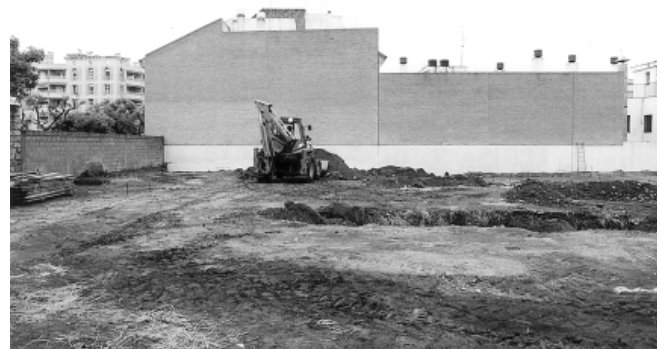
LÁM. V: Vista del lado Este en un momento de limpieza, antes de comenzar el vaciado.
