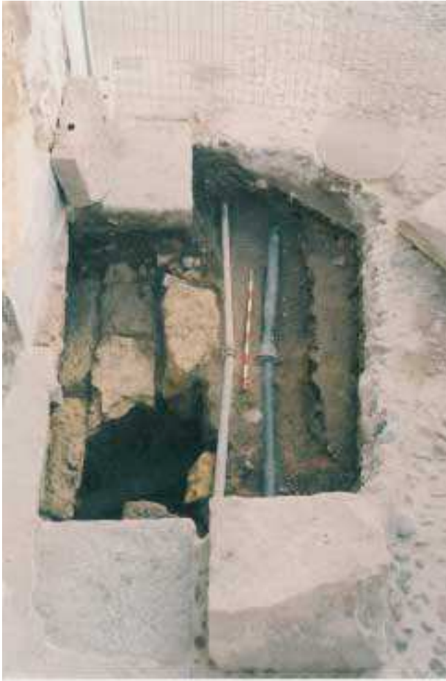
LÁM. X. Vista del sondeo practicado en la esquina SO de la Plaza de la Alhóndiga una vez finalizados los trabajos de excavación.
