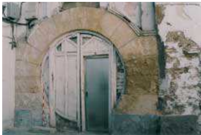
LÁM. VII. Vista del arco de herradura (U. E. 25) que forma parte de la fachada del inmueble mencionado al término de los trabajos y una vez retirado el revestimiento de cal.
