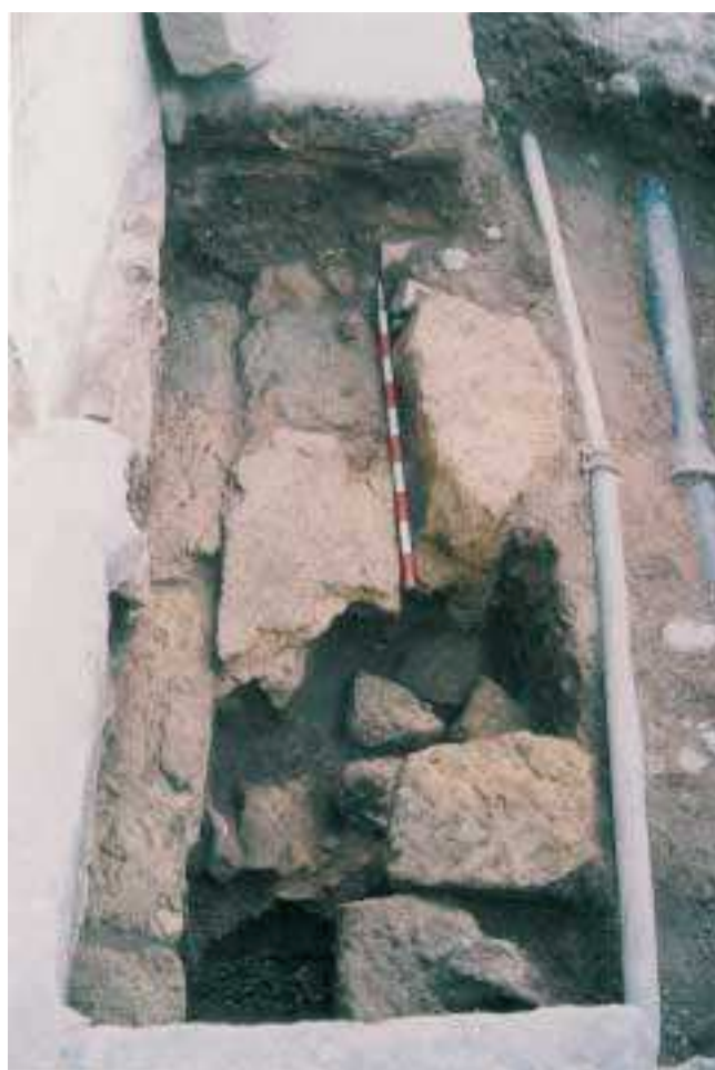
LÁM. IX. Vista desde el perfil Sur del sondeo del pavimento de losas de calcarenita (UU. EE. 20 y 22) atribuido a época bajomedieval y/o moderna.
