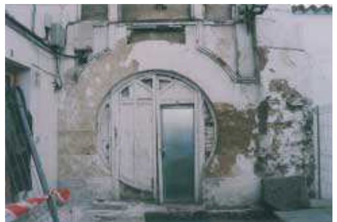
LÁM. I. Vista parcial de la fachada del inmueble situado en el ángulo SO de la Plaza de la Alhóndiga al comienzo de los trabajos.
