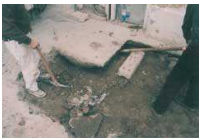
LÁM. III. Levantamiento de una de las losas que constituyen actualmente el pavimento perimetral de la Plaza de la Alhóndiga.
