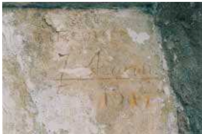
LÁM. VIII. U. E. 29: Firma del arquitecto Azorín y año de construcción del arco de herradura (1917), ambos datos inscritos en el riñón del arco.
