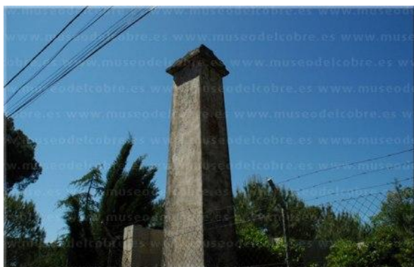
Estructura relacionada con la minería extractiva industrial.
