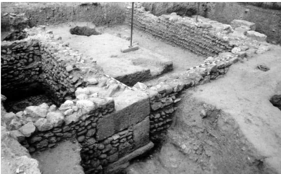
LÁM. 4: Vista general del edificio y el recinto que se le adosa.
