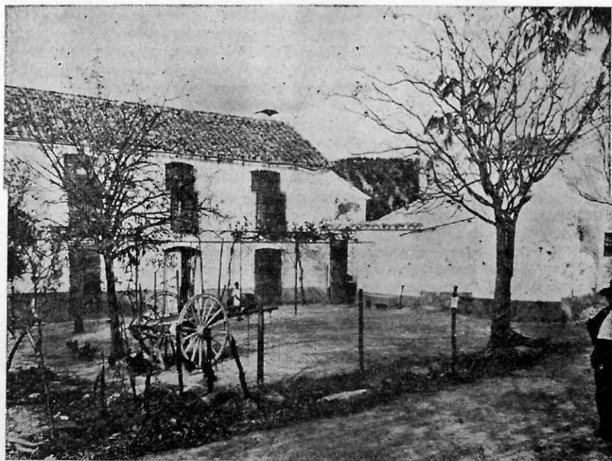
Casa de los herederos de D. José María Naranjo, en la que además de otros desperfectos, no quedó ni una sola teja sin hacer pedazos.
