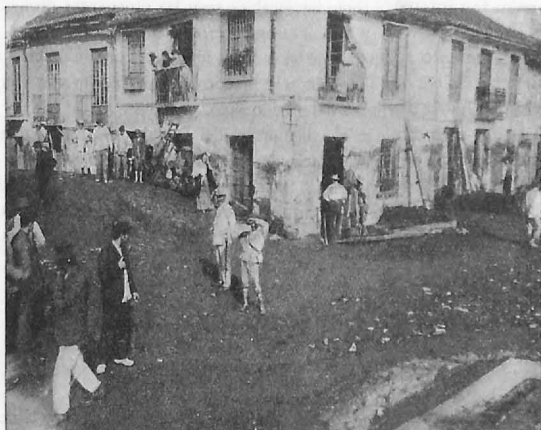
Fig. 16.—Málaga. Barrio del Perchel. Calle de la Trinidad, con los acarreos acumulados por el Guadalmedina en su avenida del 23 al 24 de septiembre de 1907. En los edificios se advierte la altura a que llegaron las aguas desbordadas.
