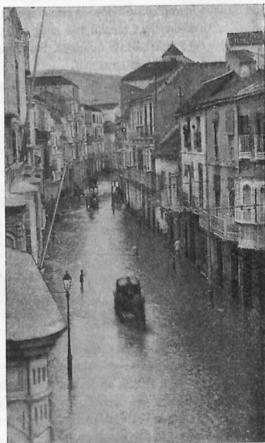
Fig. 15.—Málaga. La calle de Torrijos durante una de las inundaciones por el Guadalmedina.
