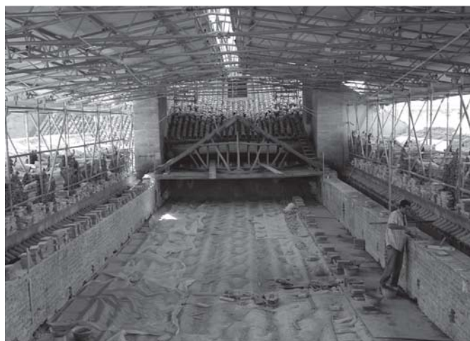
Fig. 1. Nave central de Abd al-Rahman I a la altura de cubiertas. Al fondo, bajo la armadura, el escudo del obispo Salizanes. Delante, extradós de las techumbres colocadas por Velázquez Bosco en 1919, tapadas durante las obras.
