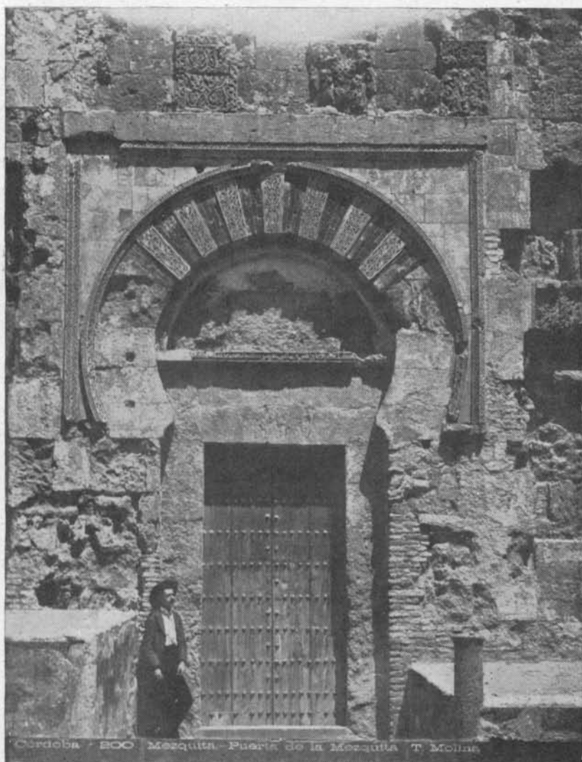
Puerta central de la fachada de Mohamed I (portada de San Esteban o San Sebastián) hacia 1890. Se nota el enclave moderno de una recomposición que afecta todo el recuadro del arco central.
