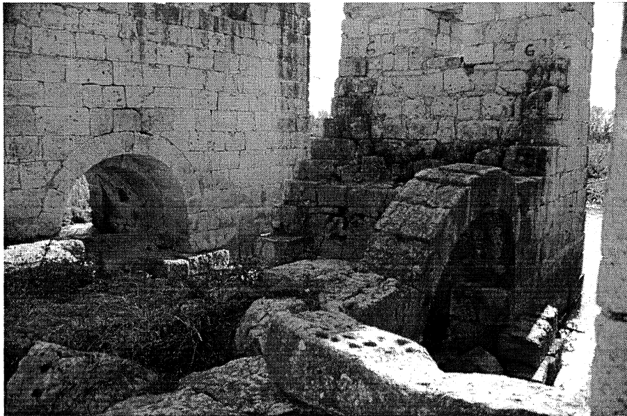
Fig. 2. Arco de separación del canal y el entresgal en aceñas de Tordesillas (Valladolid).
