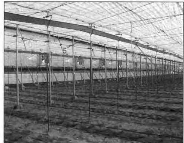
Figura 2.- Invernadero de "raspa y amagado". (1) amagado; (2) pie inclinado; (3) pie derecho; (4) tensor perimetral; (5) cumbrera o "raspa"; (6) canalón para recogida de agua de lluvia.
